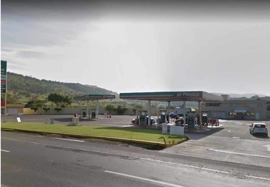
Figura 1. Vista de la estación de servicio en evaluación.
