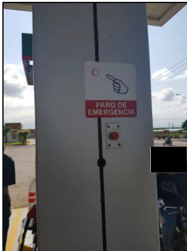
Fotografía 6. Botón de Paro de emergencia en zona de despacho de combustible.
