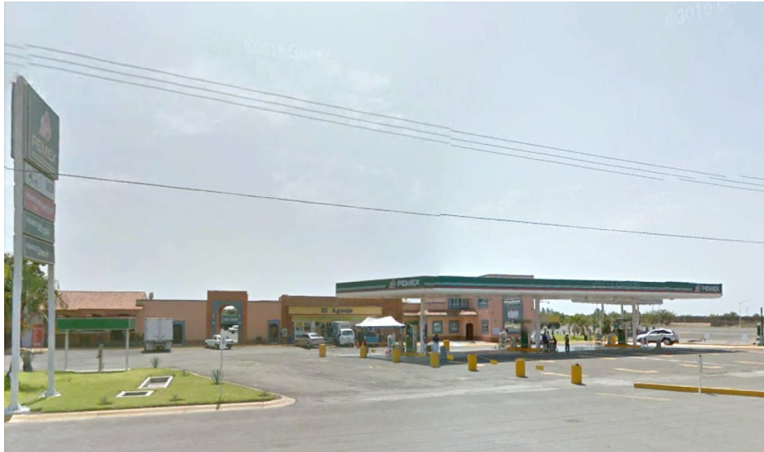
Imagen III.45 Estación de Servicio “Macro servicio del Pacífico”.
