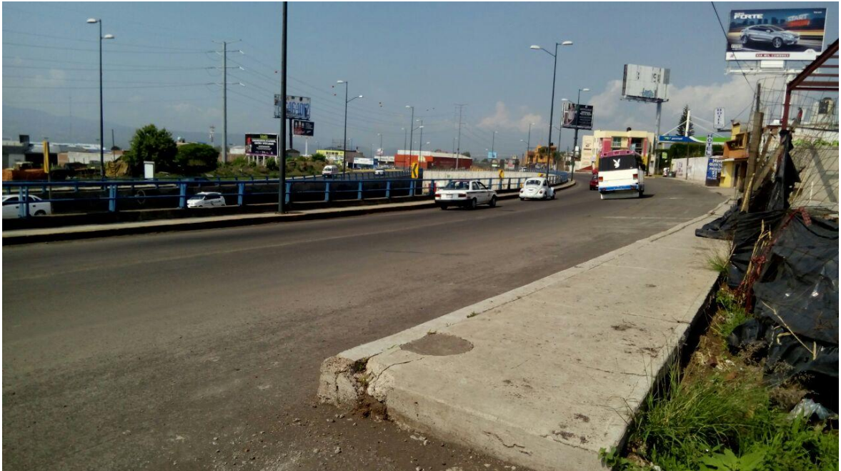
Imagen 8: Vialidad principal para llegar a la estación de compresión
