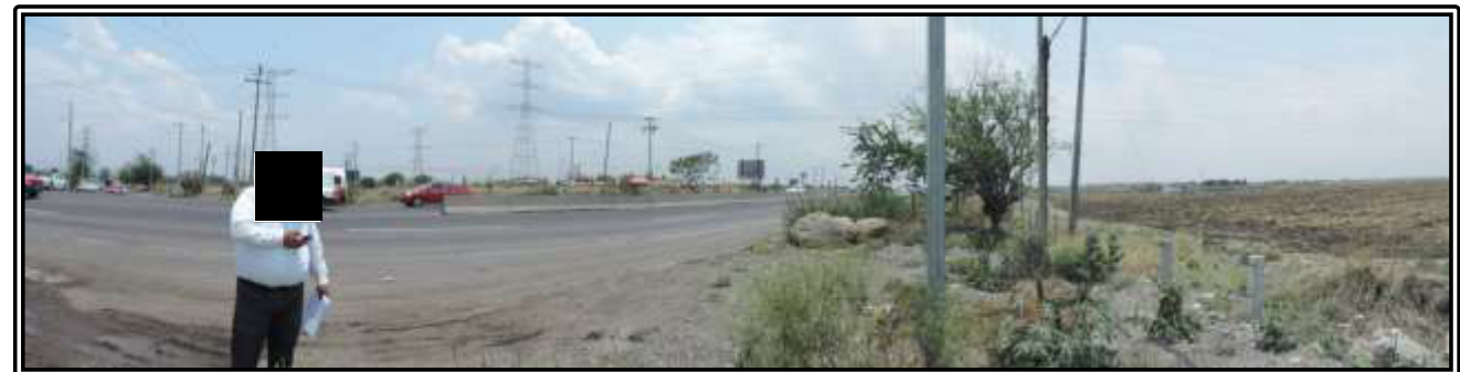
Foto VIII.1.2.1 Panorámica Frente al punto donde se ubica el registro de donde parte el gasoducto. Vista hacia el suroeste. Se identifican los postes de las líneas telefónicas y de media tensión y al fondo el cruce de las líneas de alta tensión.
