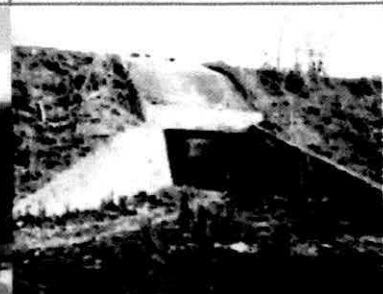
En la imagen se observa el dren pluvial que pasa en desnivel a la Carretera Internacional al Aeropuerto A.A.C.
