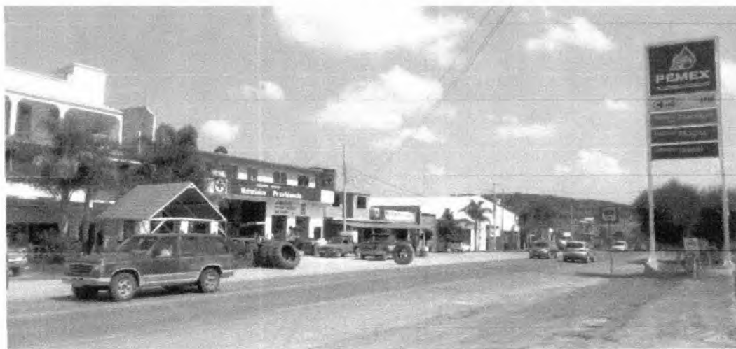
Carretera Jerécuaro-Apaseo el Alto, locales comerciales.
