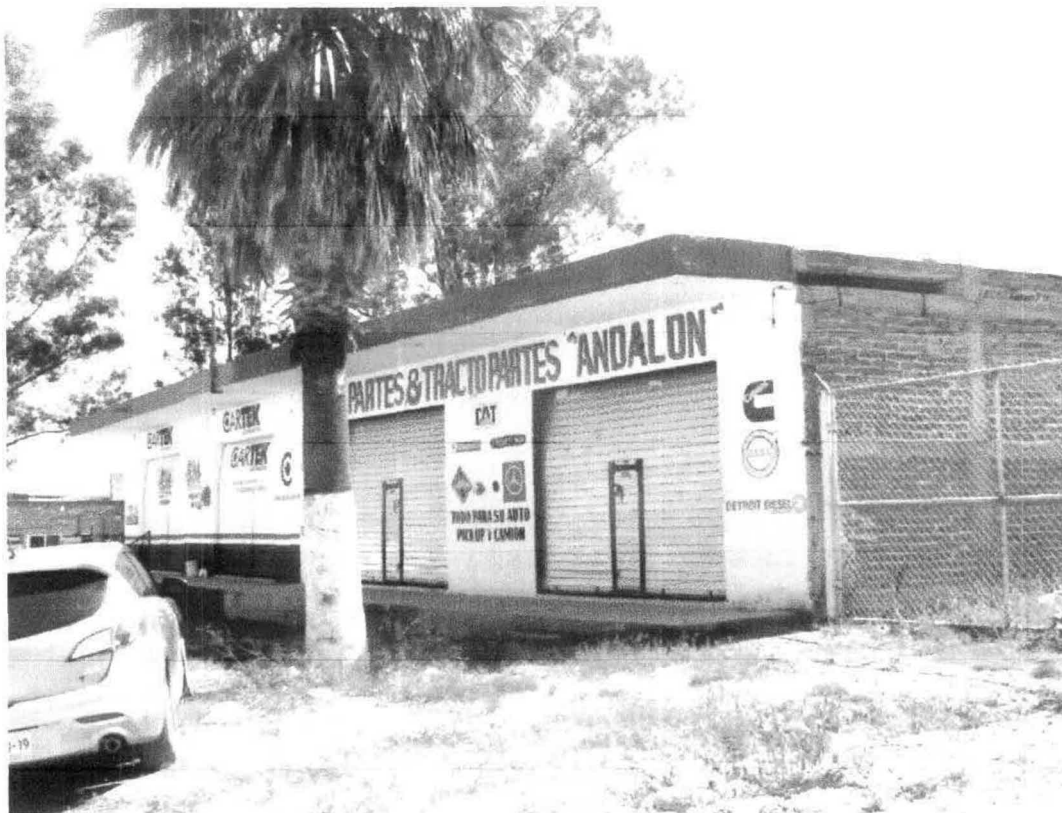
FOTO 9.- VISTA DE LOS LOCALES COMERCIALES QUE SE LOCALIZAN EN LA PARTE FRONTAL DEL SITIO EN ESTUDIO
