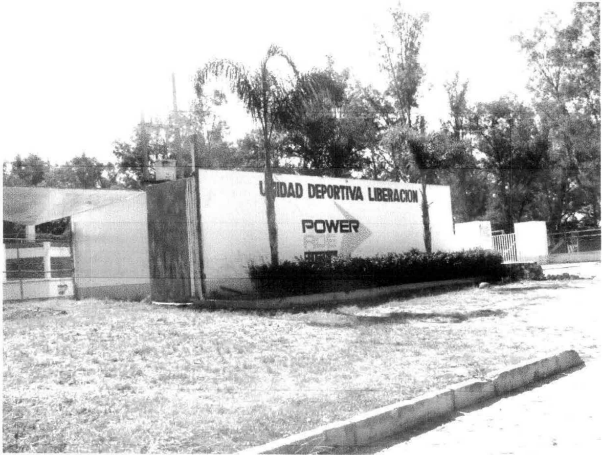
FOTO 18 Y 19.- VISTA DEL INGRESO A LA UNIDAD DEPORTIVA LIBERACION, LOCALIZADA HACIA EL OESTE DEL SITIO EN ESTUDIO
