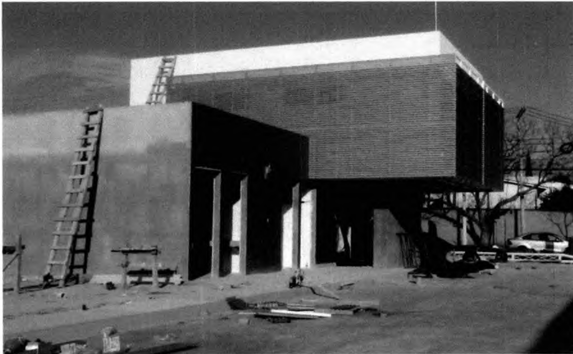
Oficinas administrativas y baños para el público en proceso de terminación
