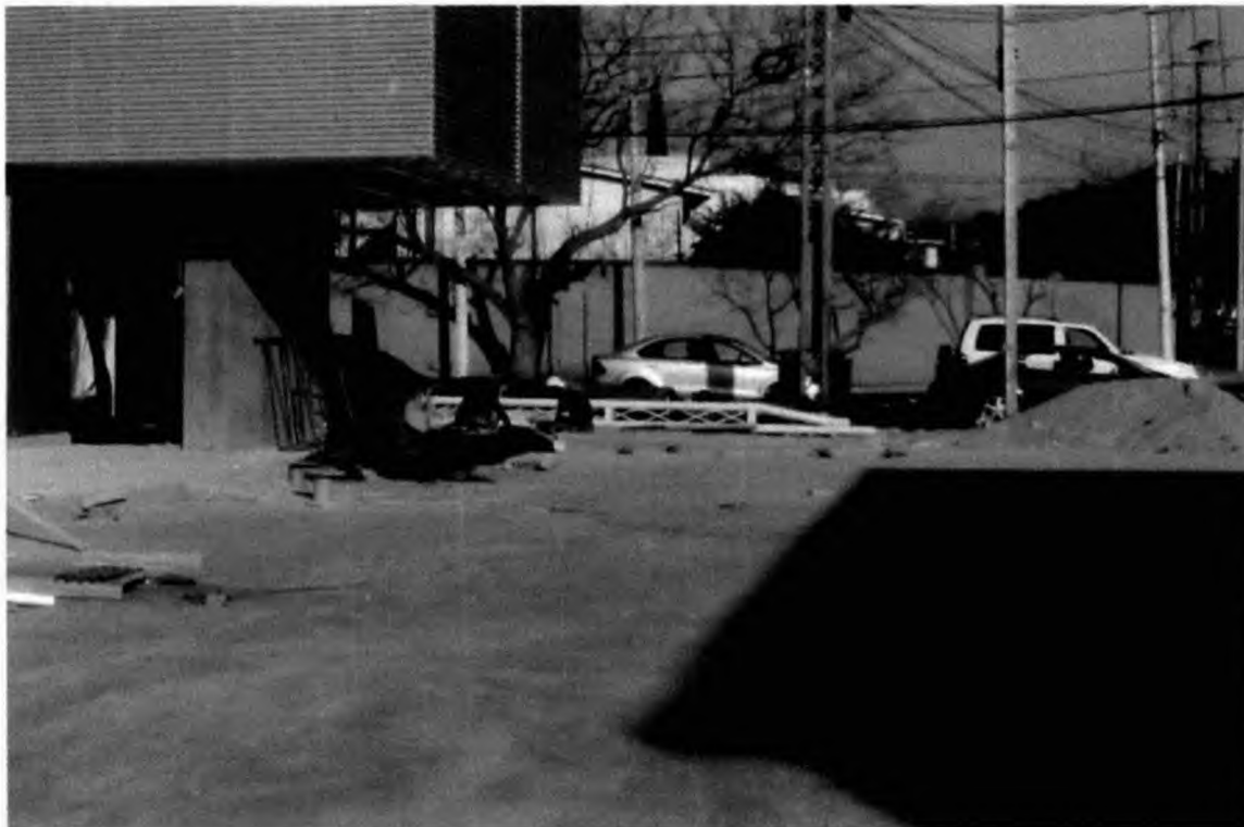
Pavimentación de áreas
