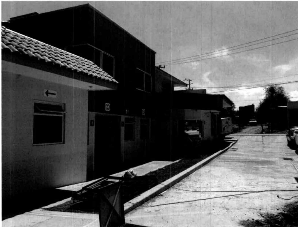
Sanitarios, tienda de conveniencia y planta alta de oficinas. Abril 2016
