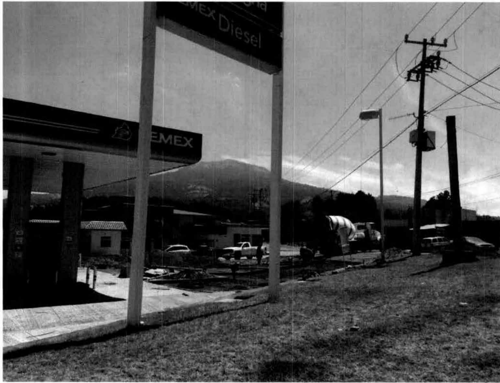
Avance General de la obra. Abril 2016
