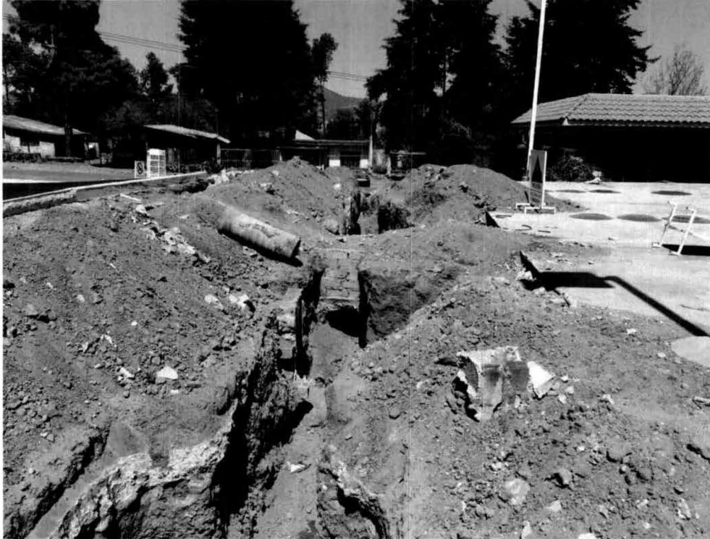
Excavación para cambio de drenaje de la línea aguas residuales y las líneas de aguas aceitosas y pluviales.
