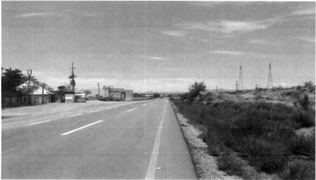
Fotografía 2. Vista de la carretera hacia el norte.
