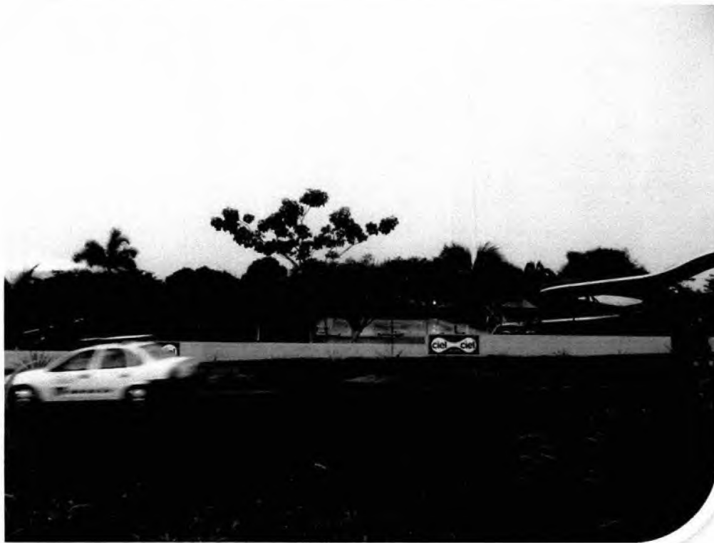
Vía de acceso al proyecto, la Carretera Ometepec-San José Ejido
