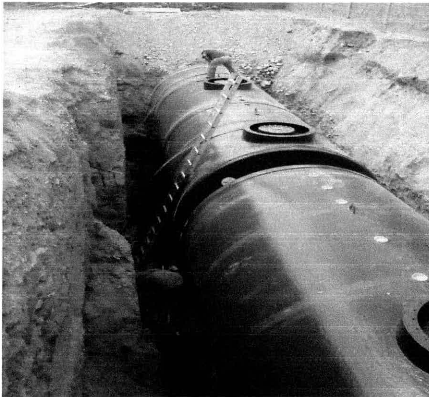
Foto 7. Área de tanques (Marzo 2015)
