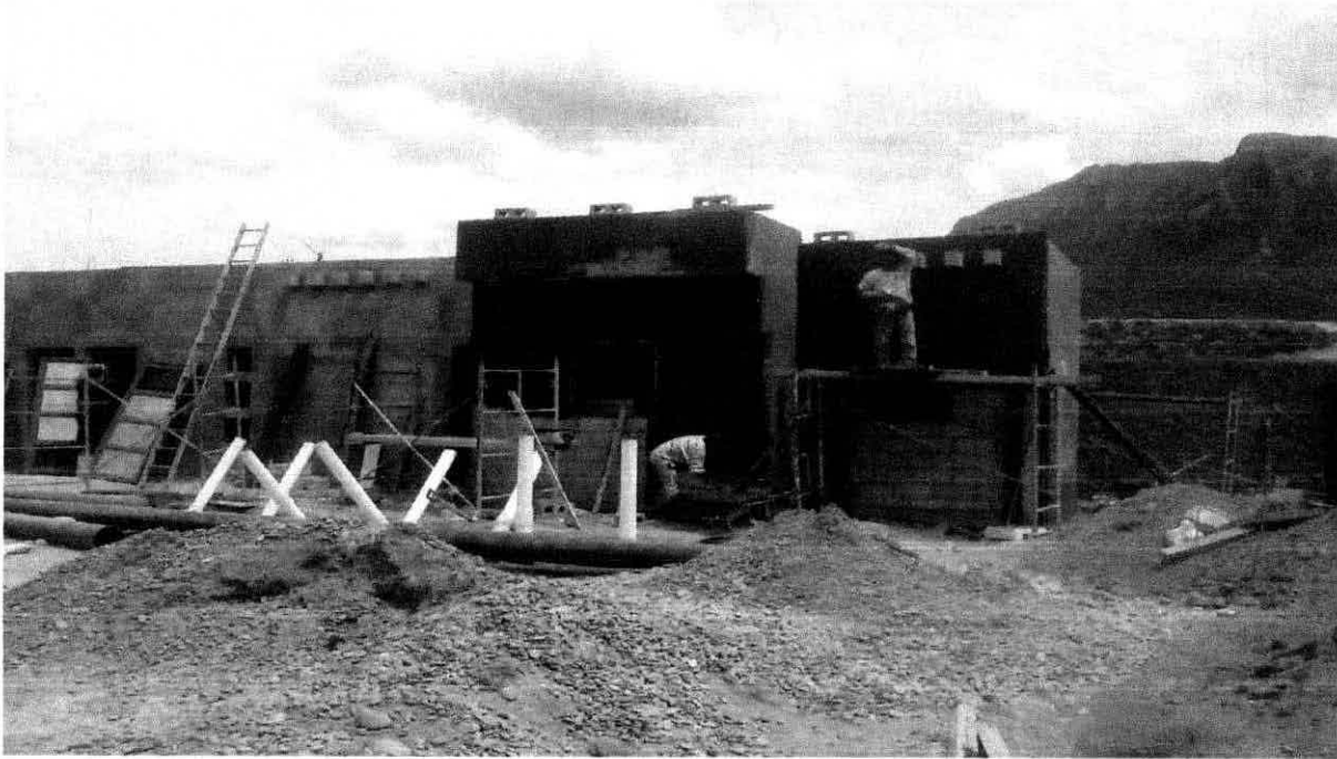
Foto 6. Área de oficinas (Marzo 2015)
