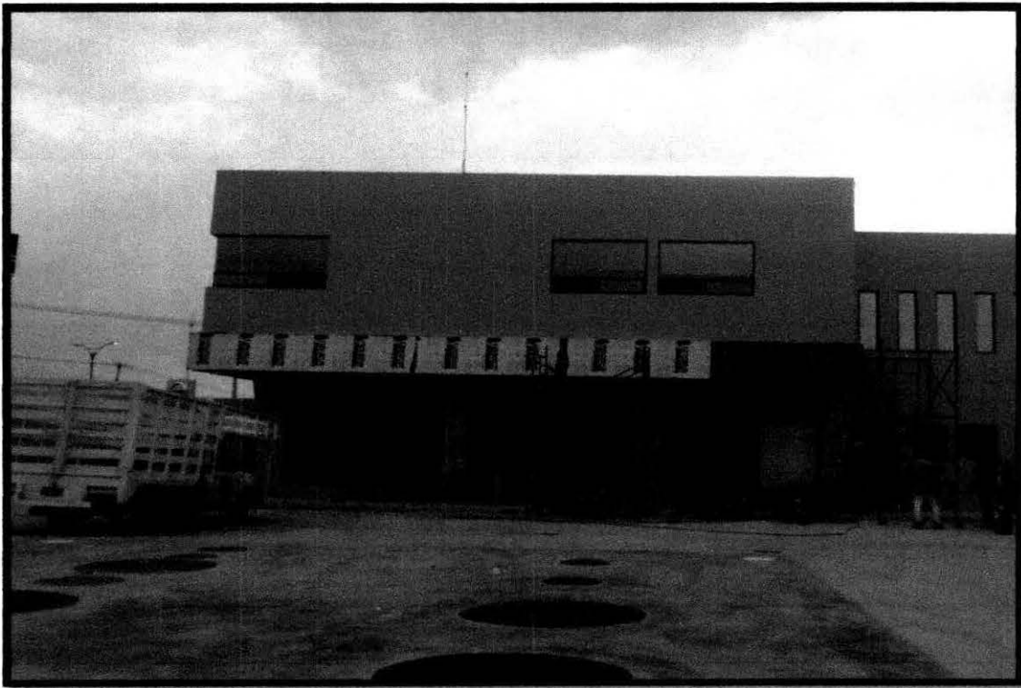
Imágenes en las que se aprecia el avance en la obra civil del proyecto
