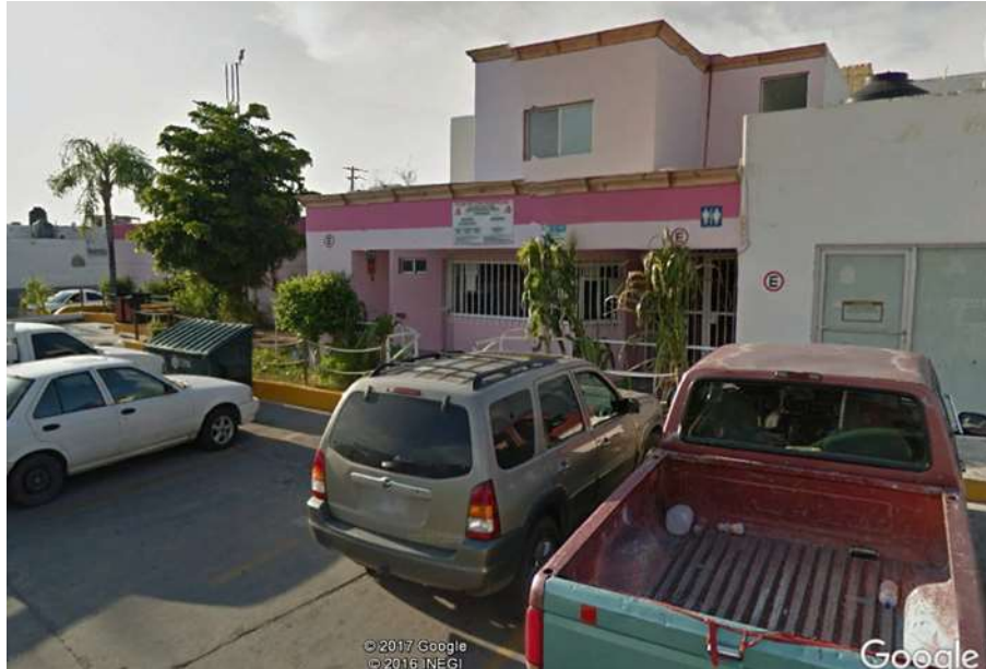
Oficinas de la Estación de Servicios
