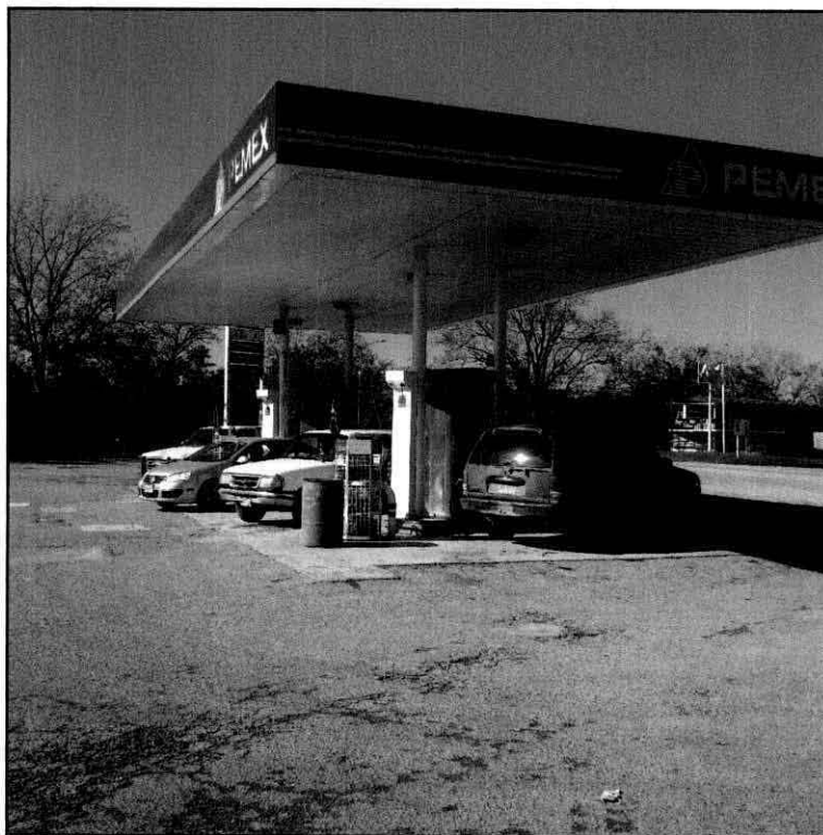
Imagen 2. Vista de los dispensarios de la estación de servicio.
