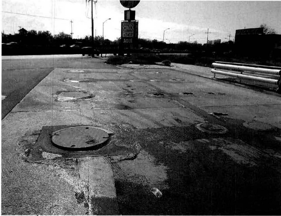
Figura 5. Área de tanques de almacenamiento de la estación de servicio.
