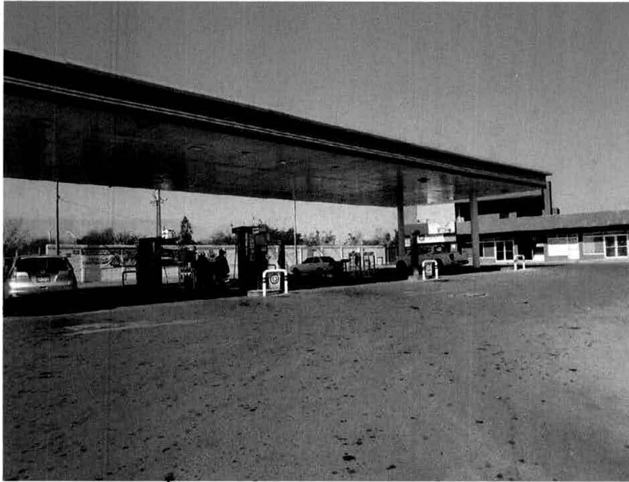
Figura 1. Área de despacho de la estación de servicio.
