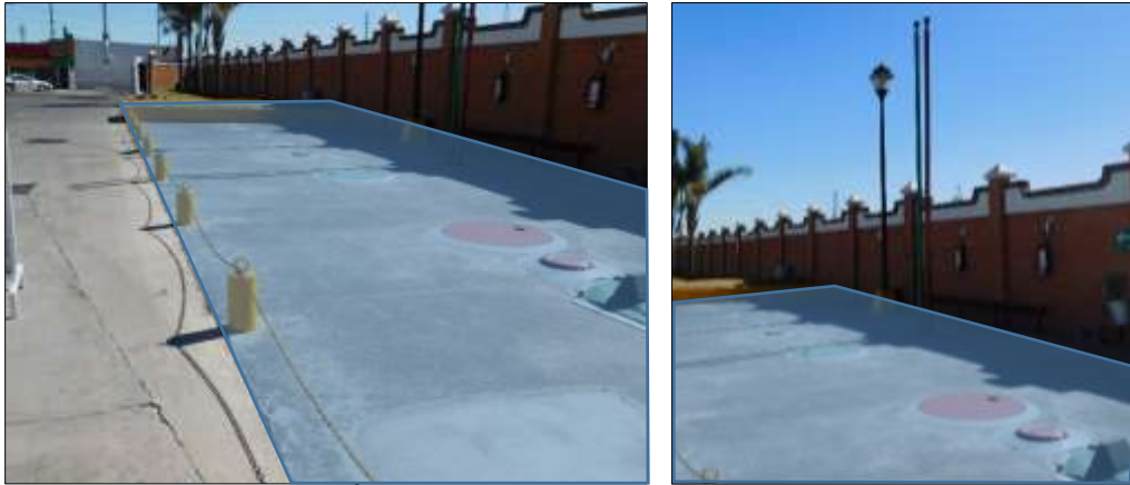
Figura 4. Área de almacenamiento de combustibles.
