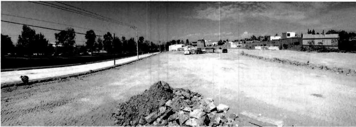
Figura 13. Vista panorámica del predio del proyecto. (calle lateral de Av. Aguascalientes en construcción).
