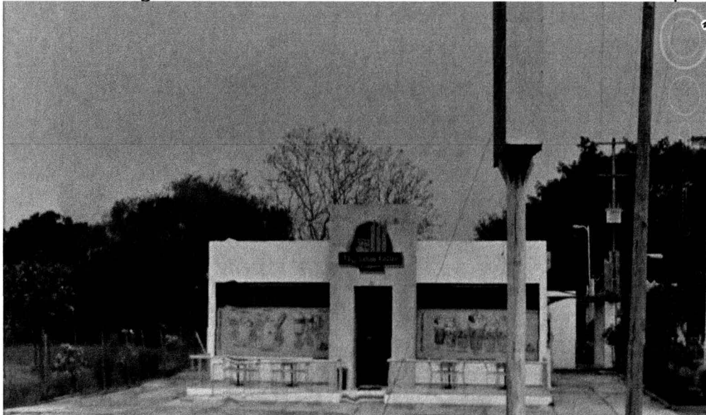
Fig. III.4.7 Vista de las instalaciones ubicadas al sur del predio.
