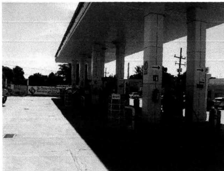
Fotografía de la zona de despacho, donde se muestran las bombas para el despacho del combustible.
