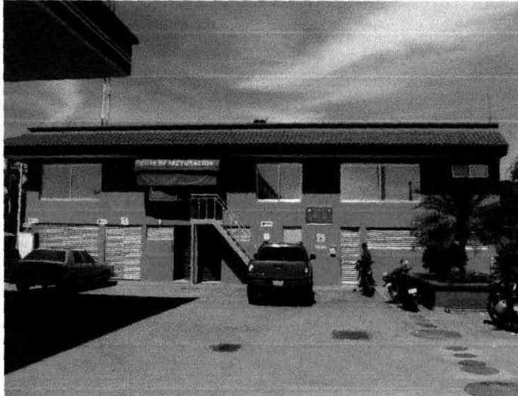
Edificio de oficinas y baños de la estación de servicios.
