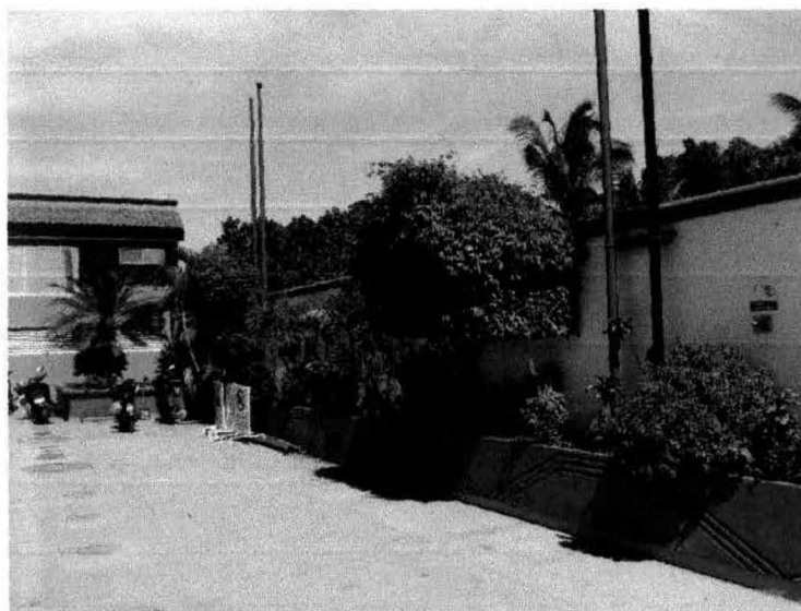
Fotografía del área verde de la estación. En ella se observa la zona de tanques de almacenamiento
