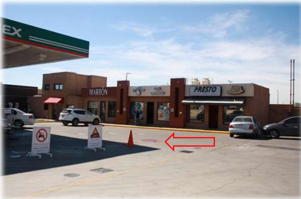
En la fotografía se observa el área comercial al fondo, también se indica con flecha roja la ubicación del área de tanques.
