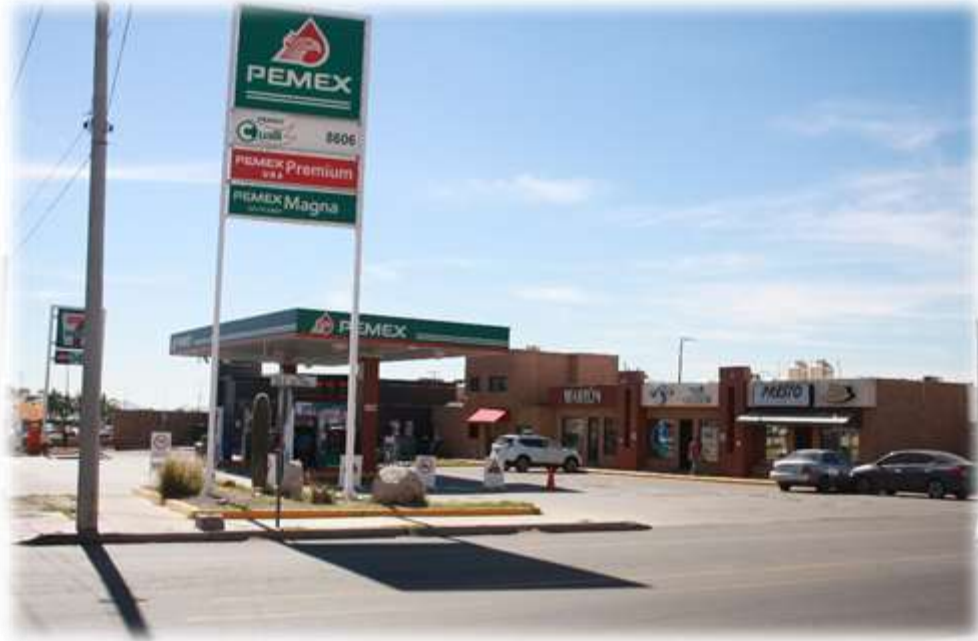
Vista completa de la estación.
