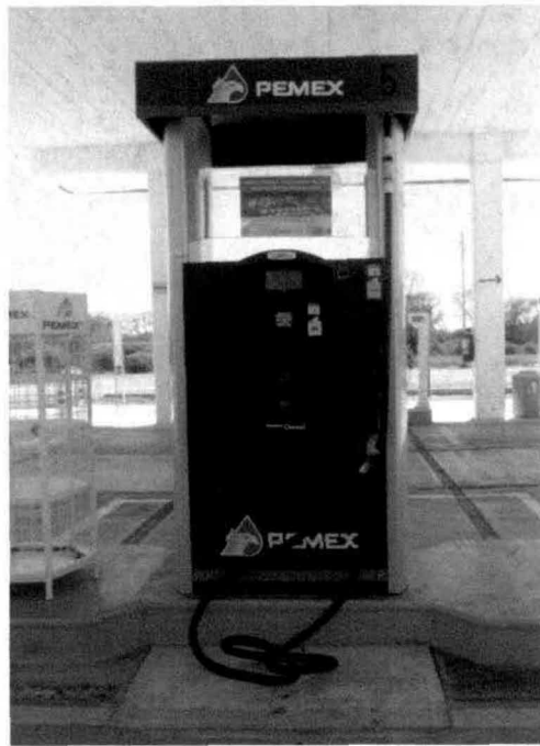
Dispensario 7-8: Dos mangueras para despacho de Diésel.
