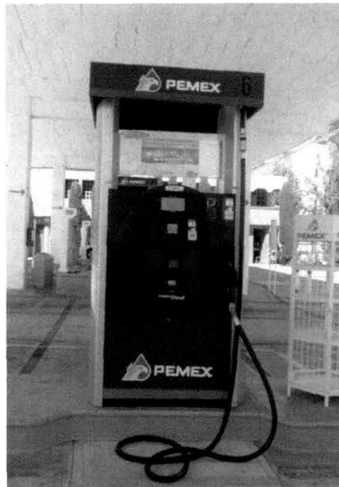
Dispensario 7-8: Dos mangueras para despacho de Diésel.
