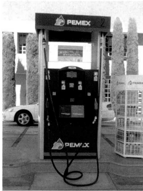
Dispensario 3-4: Dos mangueras para despacho de PEMEX Magna dos mangueras para despacho de PEMEX Premium.
