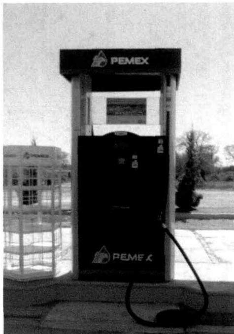
Dispensario 7-8: Dos mangueras para despacho de Diésel.
