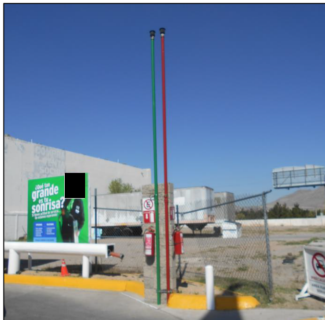
Imagen 4. Área de venteo para gasolina magna y gasolina premium.
