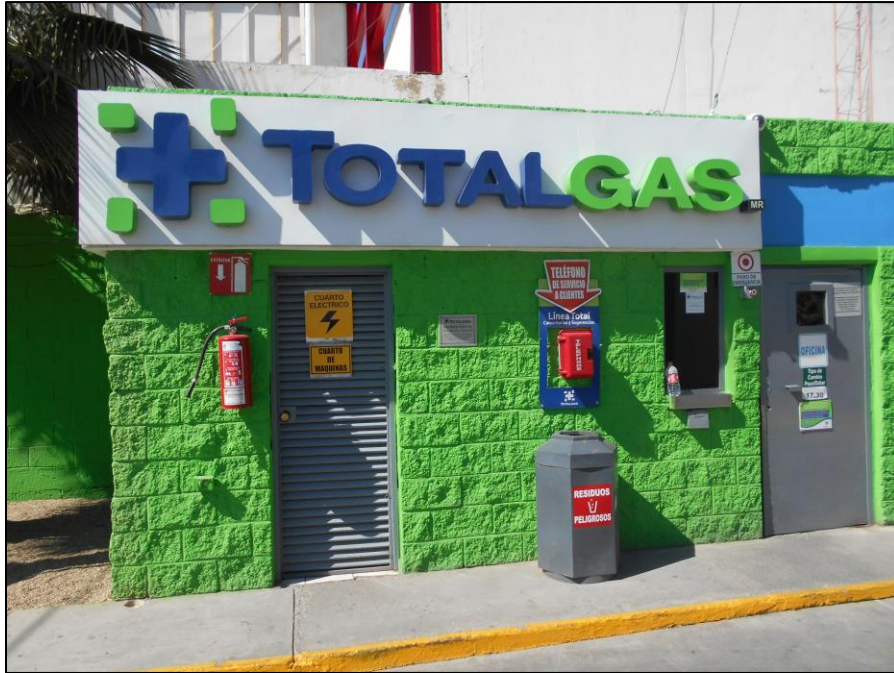
Imagen 3. Área de cuarto eléctrico y cuarto de máquinas.
