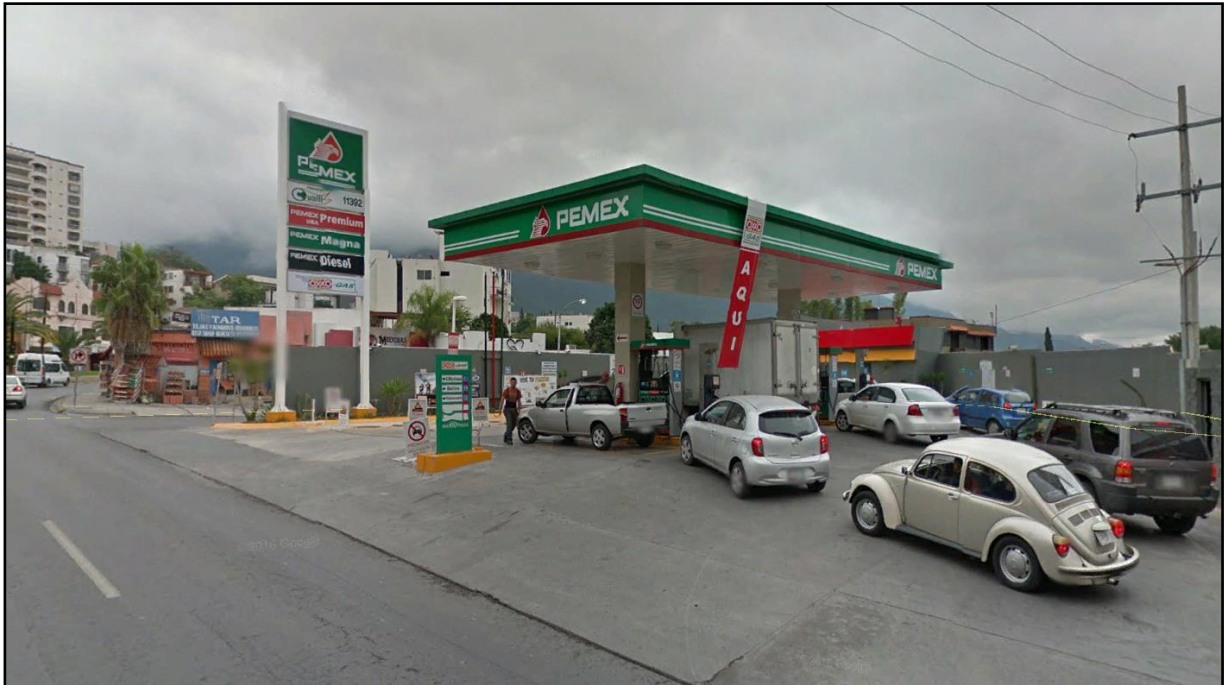
Imagen 1. Vista de la estación de servicio.
