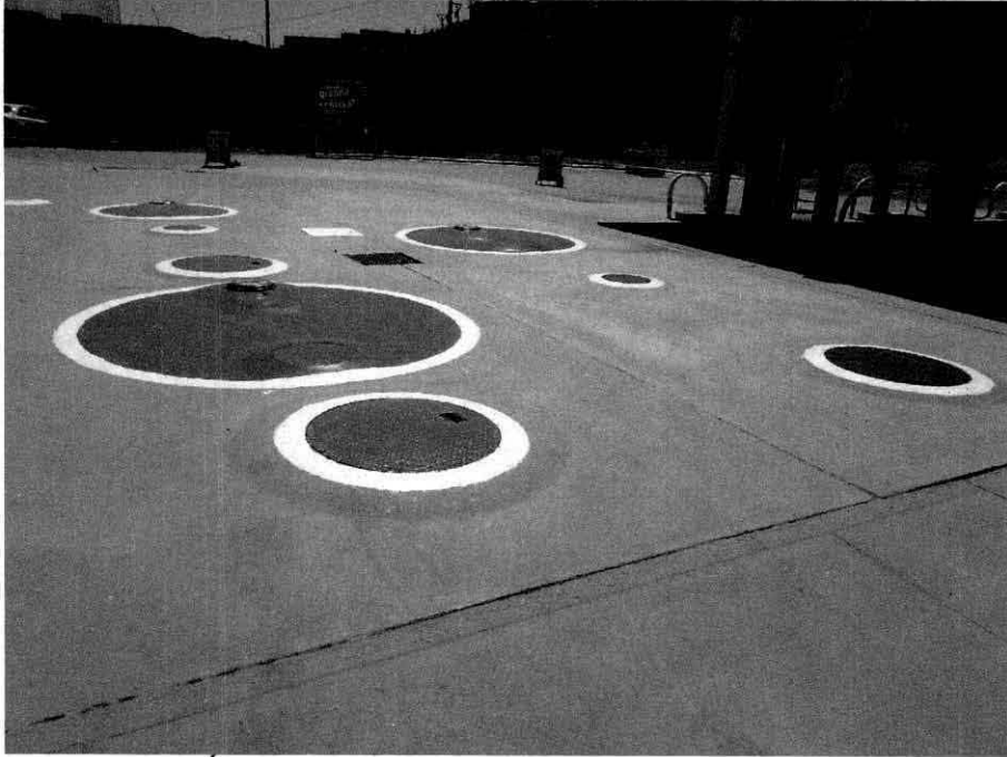
Figura 3. Área de tanques de almacenamiento de petrolíferos.
