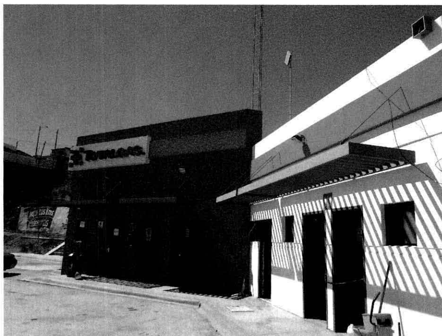
Figura 2. Área de oficinas de la estación de servicio.
