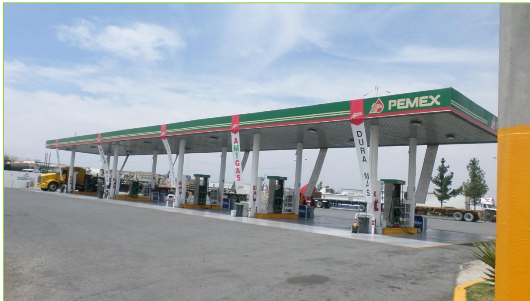
Figura 15. Zona de despacho de la E.S. 06100.
