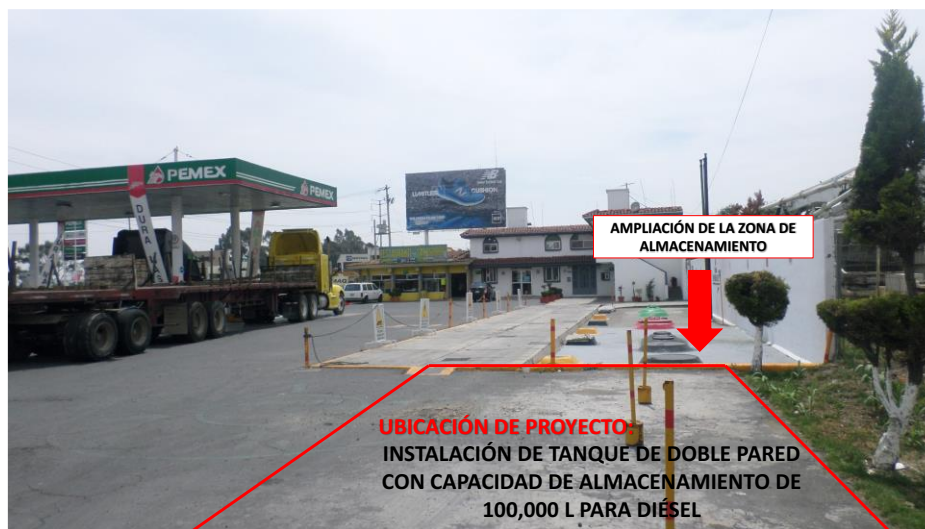
Figura 5. Ubicación de nuevo proyecto: instalación de tanque.
