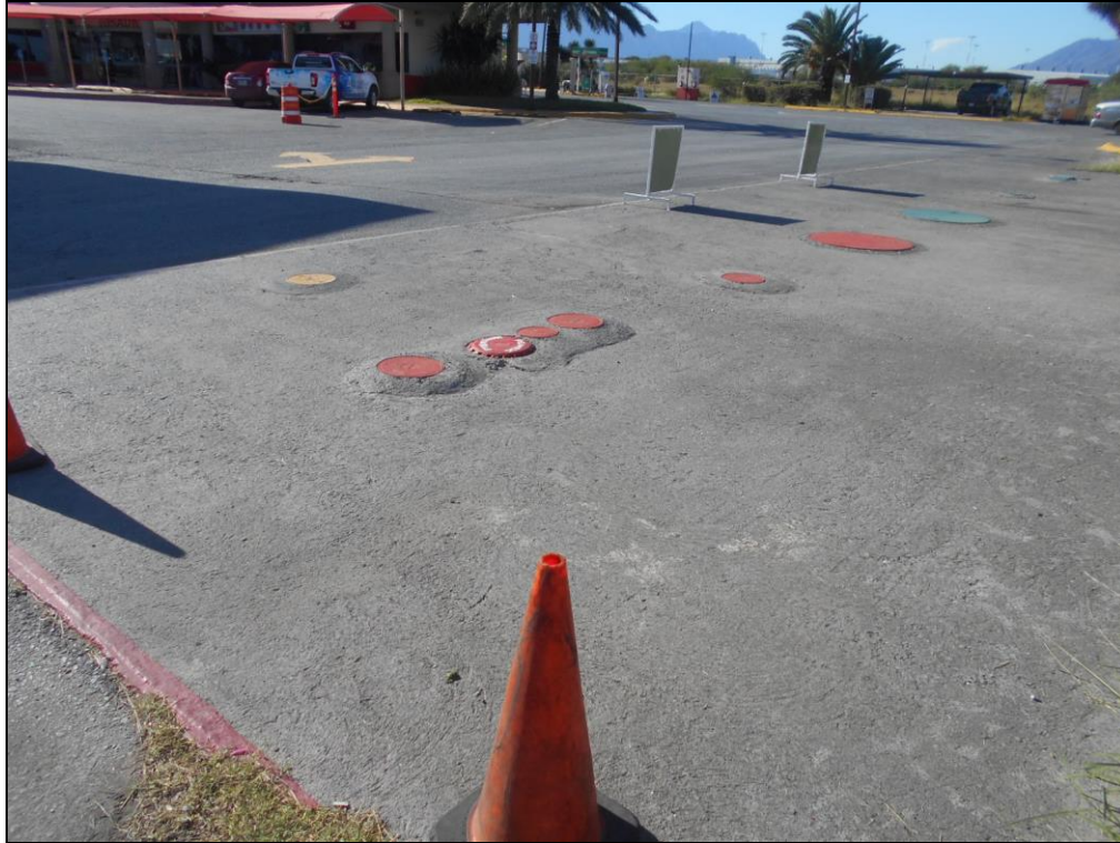
Figura 3. Área de tanques de almacenamiento.
