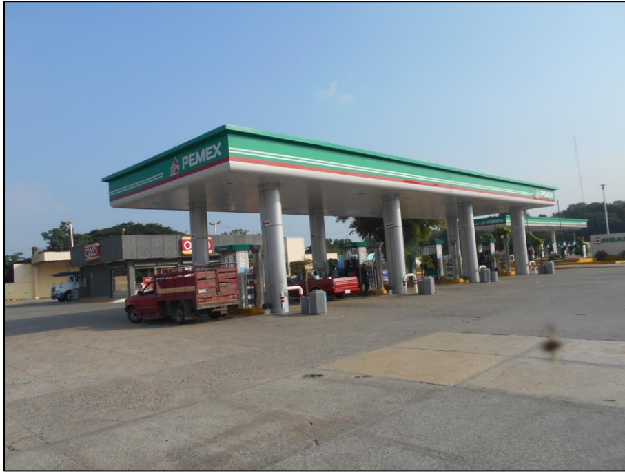
Imagen 1. Estación de servicio.
