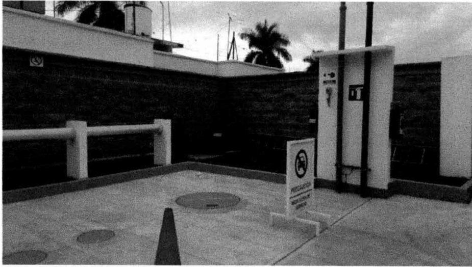
Imagen 4. Otra vista del área donde se ubica el tanque y los tubos de venteo.
