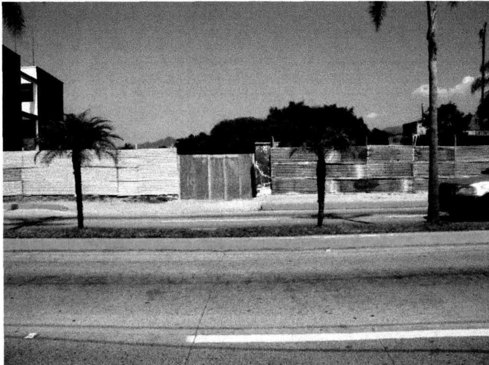
3. Aspecto actual del acceso al predio.
