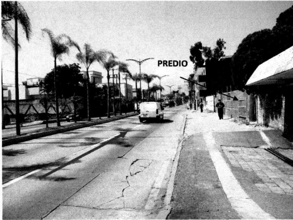
1. Avenida 1, vialidad que será el acceso a la futura gasolinera. Vista con dirección a Fortín, Ver.
