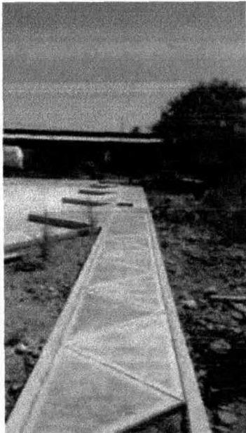
Cajones de estacionamientos y banquetas.
