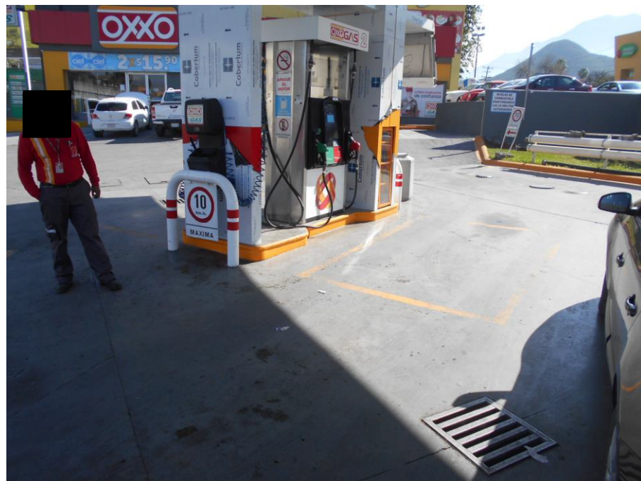
Figura 2. Dispensarios de la estación de servicio.
