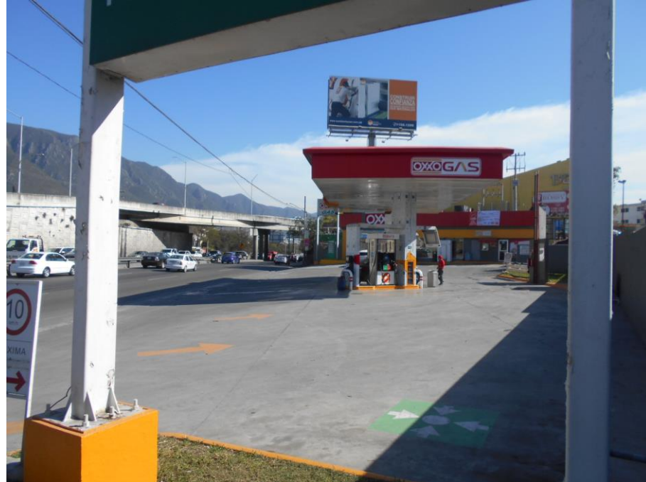
Figura 1. Área de despacho de la estación de servicio.
