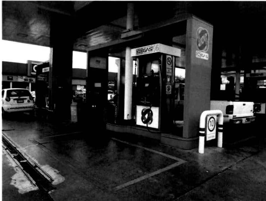
Figura 2. Dispensarios de la estación de servicio.
