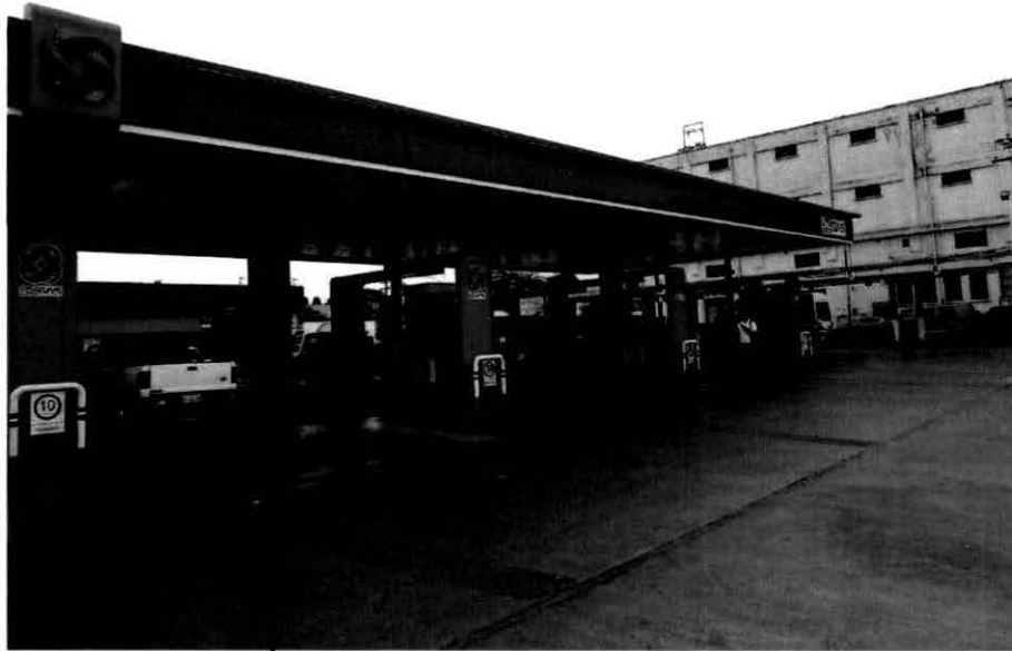
Figura 1. Área de despacho de la estación de servicio.
