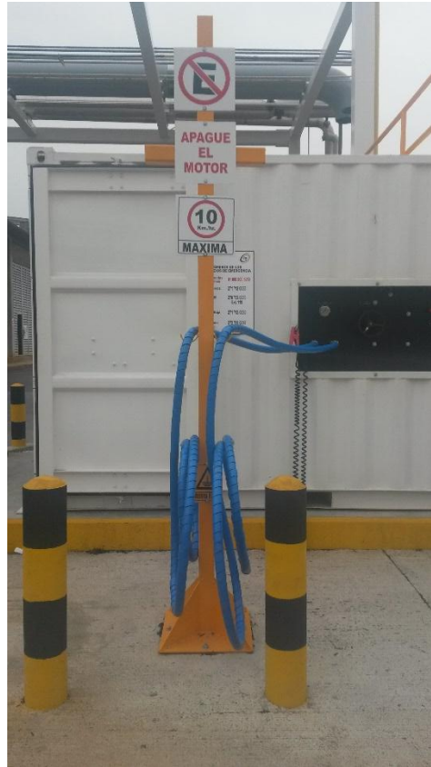
Fig. 8 Entrada de gas al descompresor.
