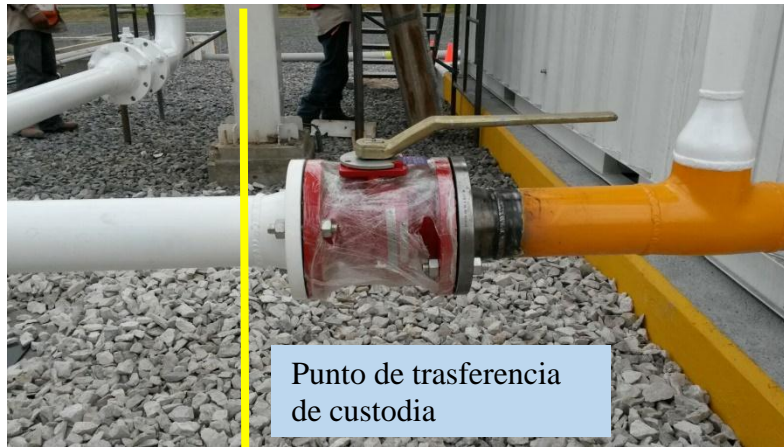
Fig. 10 Punto de transferencia de custodia.
