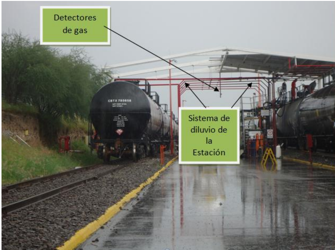
Figuras 19. Ejemplo de Estación equipada para trasvase de combustibles líquidos.
