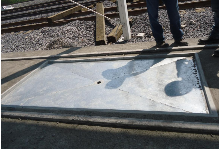
Figura 35. Charola fija para derrames en estación de trasvase de diésel y gasolina.
