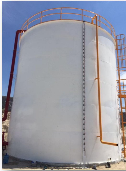
Figura 34. Tanque de agua para el sistema contra incendios.
