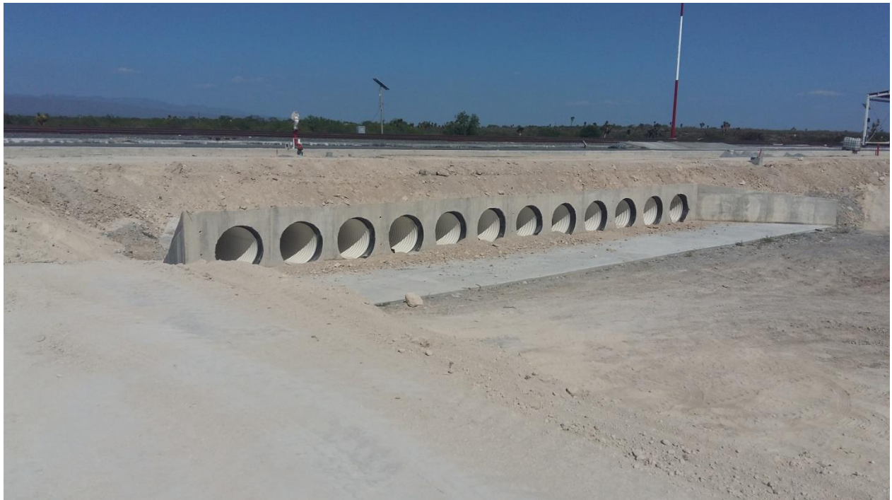
Fig. # 2. Construcción de puente en la Terminal (que permita correr caudal pluvial).
