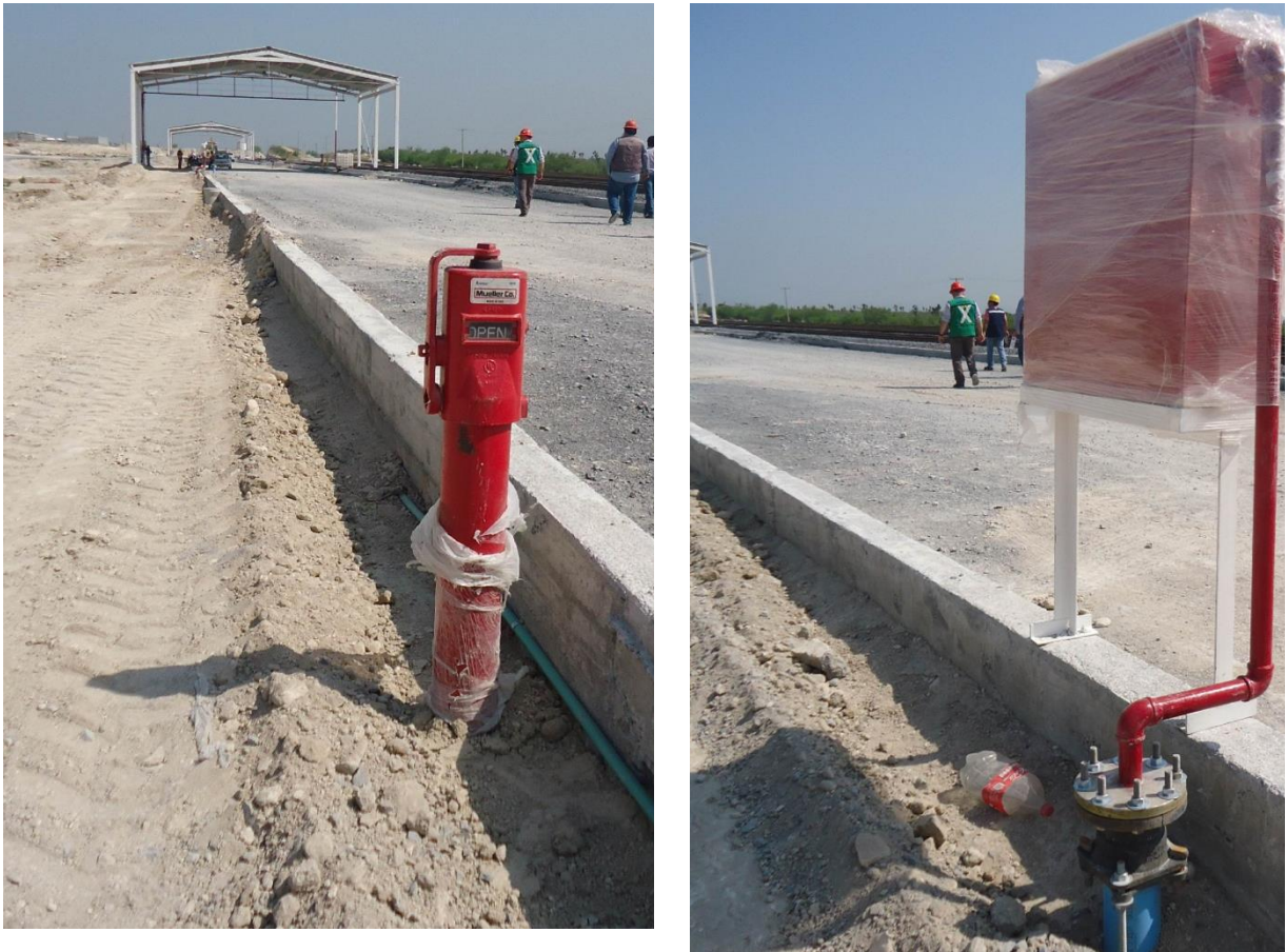
Fig. # 16. Cañones y mangueras cerca de las Estaciones de trasvase.
