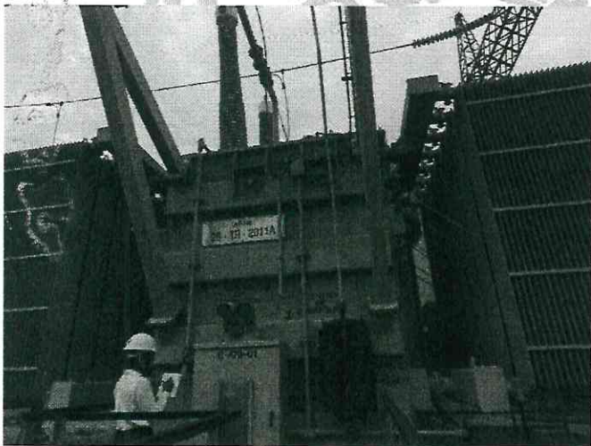
Transformador TR-2011A, en cuya placa se menciona que no contiene PCB's
