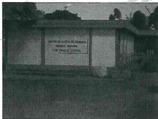
Centro de Acopio de Residuos de Manejo Especial
