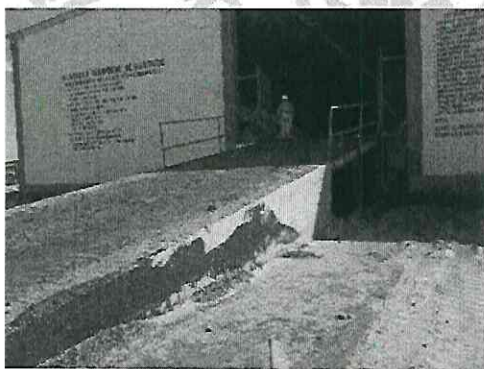
Acceso a almacén, rampa metálica
