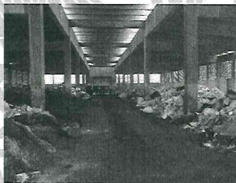
El almacén Temporal de Residuos Peligrosos se excede el volumen de las celdas
