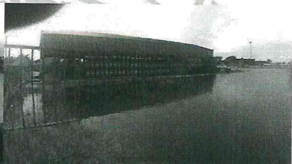
Acumulación de agua y tambos de catalizador a un costado de almacén temporal
