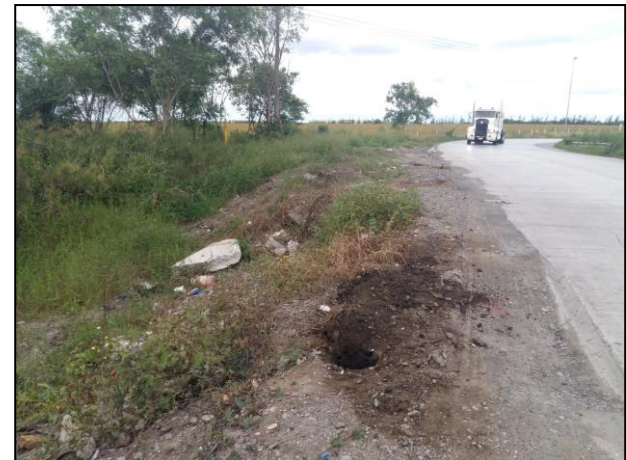
4 – Se realizaron sondeos en el sitio, además se observa la presencia de abundante basura y escombros.
