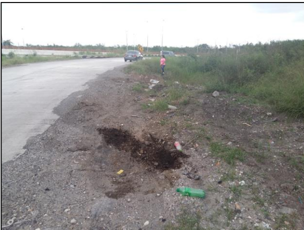
3 – El contaminante (Diésel) afectó suelo natural del derecho de vía de la Carretera Tampico – Ciudad Mante, tal como se puede apreciar.
