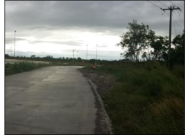
2 – El accidente ocurrió en una lateral de la Carretera, cercano a un puente carretero, se observa el suelo natural afectado.
