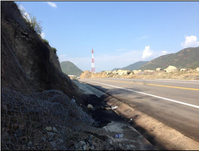
1.- Sitio del accidente, en el Km 247 + 400 de la Carretera (37-D) Uruapan – Lázaro Cárdenas, en el municipio de Lázaro Cárdenas, estado de Michoacán.
