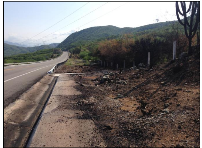
4.- El hidrocarburo se desplazó por una canaleta de concreto que se encontraba a un costado de la Carretera (37-D), afectando suelo natural.
