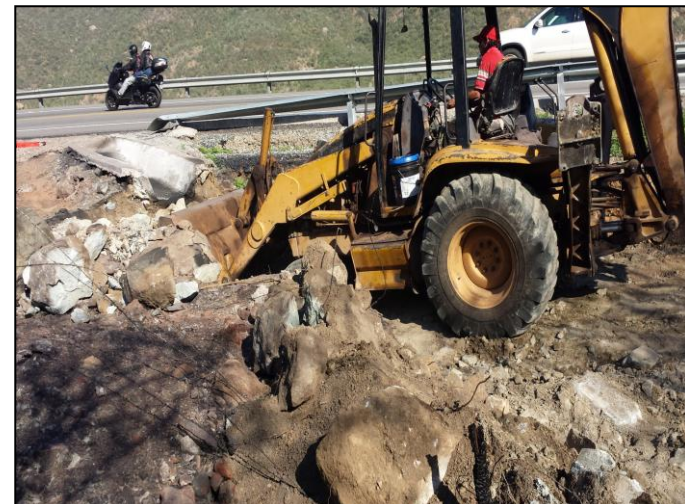
4.- Con apoyo de maquinaria pesada, se realizó la extracción de material edáfico afectado.
