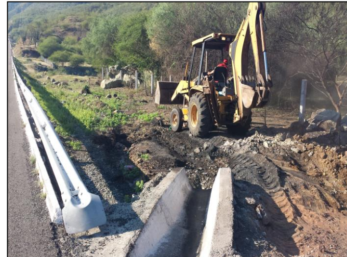
2.- Acondicionamiento del sitio para la construcción de la celda provisional.
