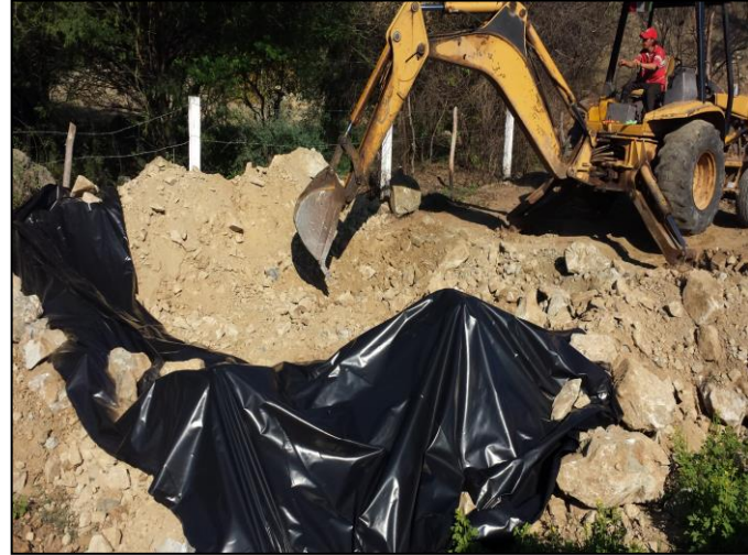
6.- Deposito de material edáfico en celda provisional con ayuda de maquinaria pesada.
