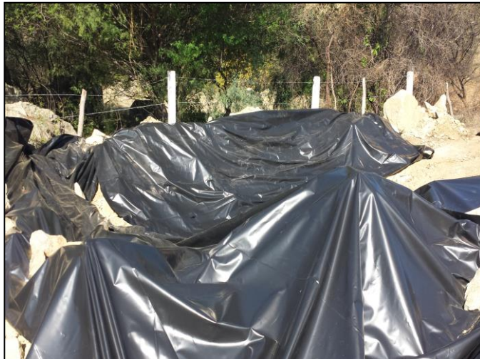
3.- Se cubrieron los bordos de la celda con una película de polietileno de alta densidad.
