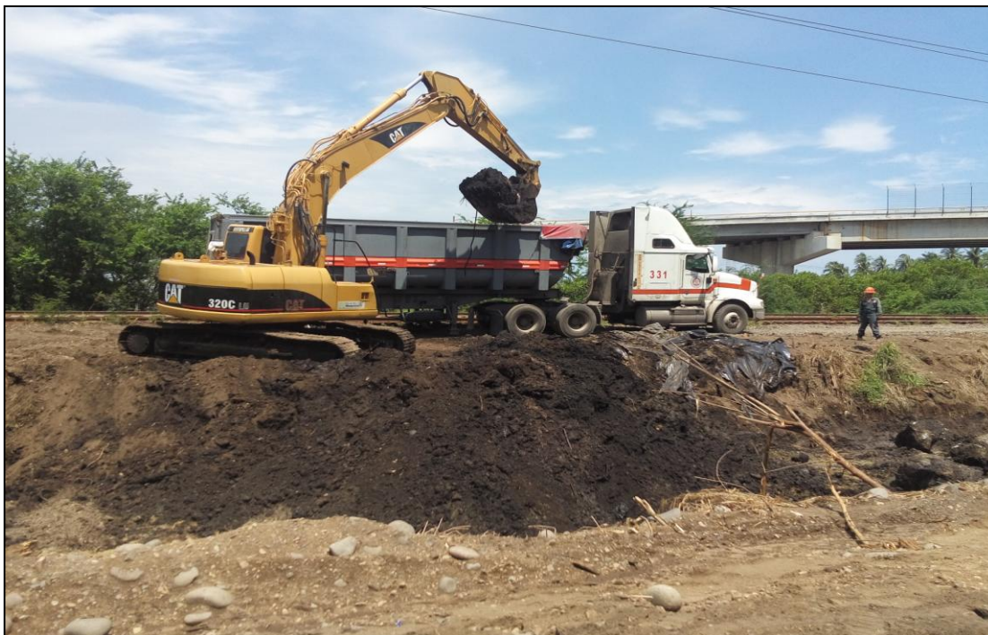
Figura 2: Retiro de material saturado de COPE de la zona afectada
