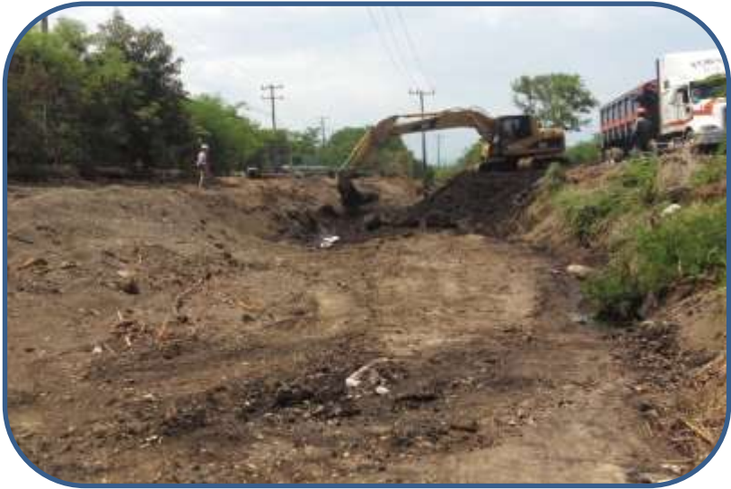
Vista de Remoción de Suelo Saturado
