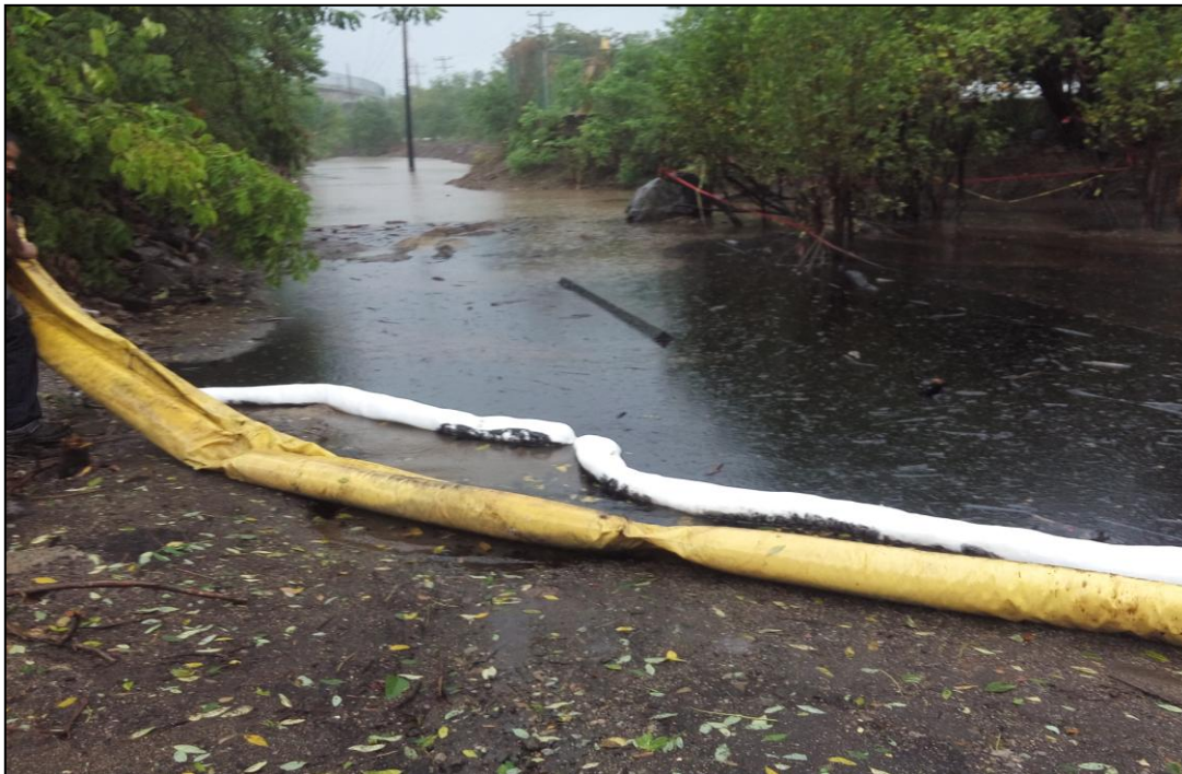
Figura 5: Vista general de la afectación pluvial
