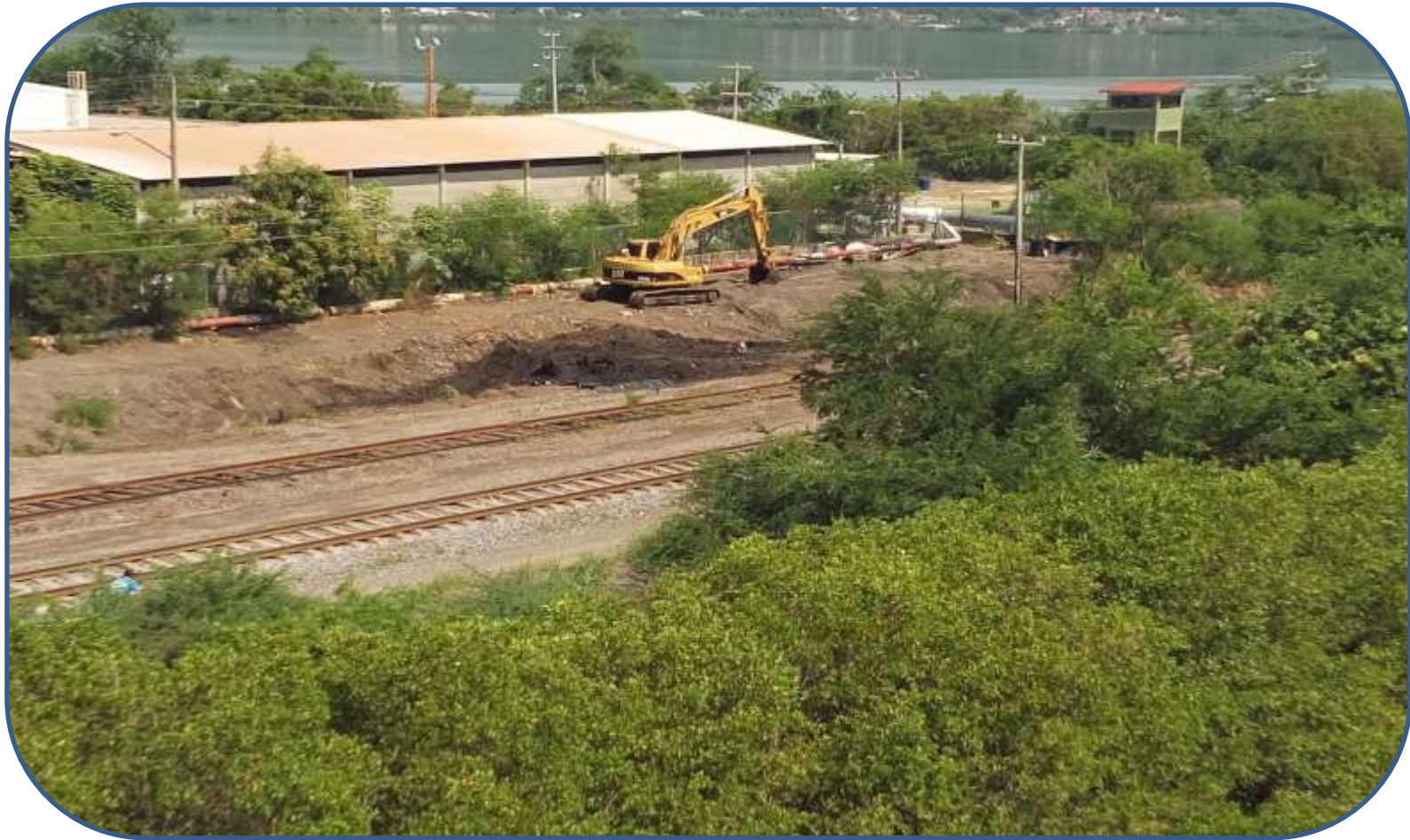
VISTA GENERAL DE LA ZONA AFECTEDA
