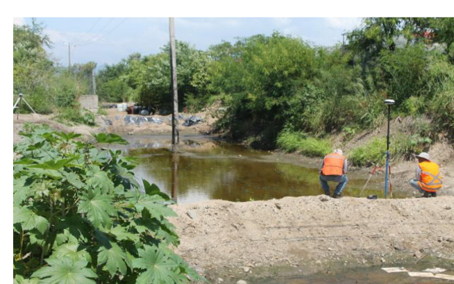
Vista de Dique 3 hacia Dique 1
