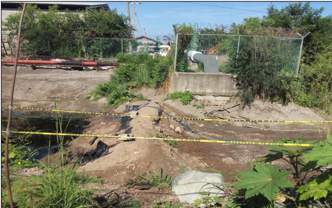
Figura 10: Vista de ductos existentes en el área afectada.
