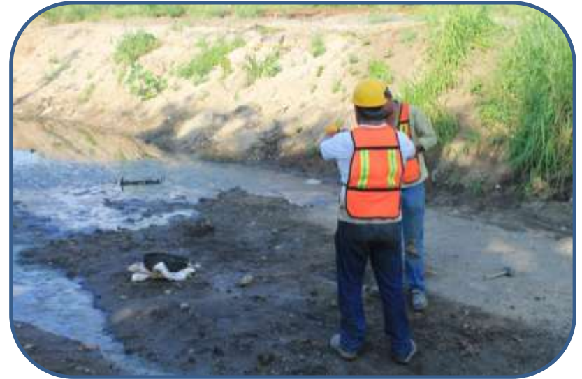
Perforación del Barreno S6
