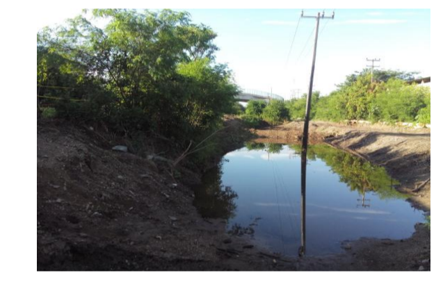
Vista de Dique II al Dique III
