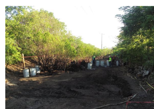
Vista de Dique 1
