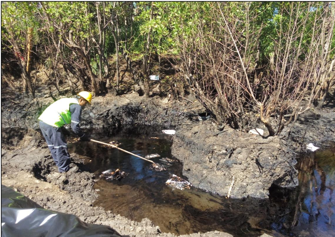
Figura 3: Recuperación de COPE por medio de utilización de Material oleofílico e hidrofóbico, en la zona de los mangles afectados.
