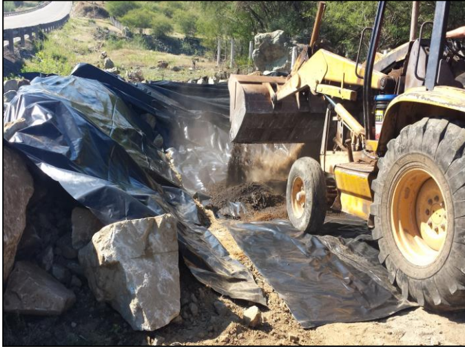
5.- Acarreo de material edáfico afectado a celda provisional.
