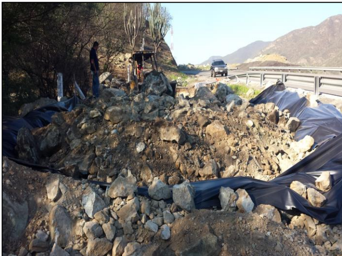
7.- Depósito de material edáfico afectado en celda provisional.
