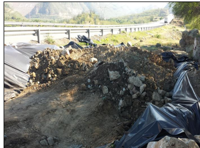
8.- Vista final de la celda provisional.
