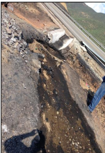
5.- El hidrocarburo se desplazó por la canaleta de concreto hasta desembocar sobre suelo natural.
