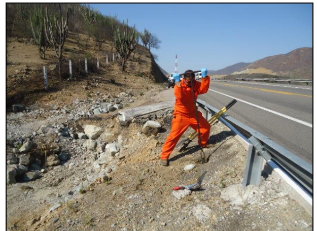
4. Toma de muestra en una de las paredes de la fosa de excavación (caja de extracción).
