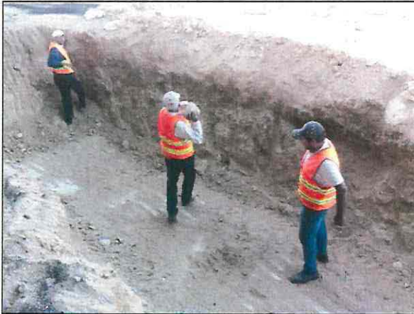
Con apoyo de recurso humano se detalló la fosa de excavación (caja o zona de extracción).
