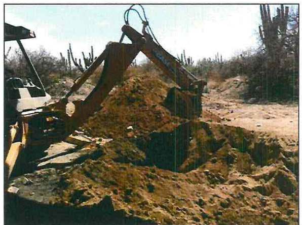
Con apoyo de retroexcavadora se extrajo el suelo natural contaminado con hidrocarburos (Turbosina).
