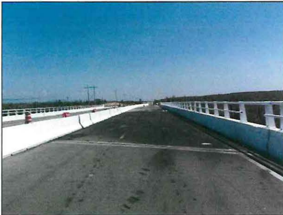
Ubicación del punto de impacto en el Km. 41 + 590 de la Carretera No. 19.
