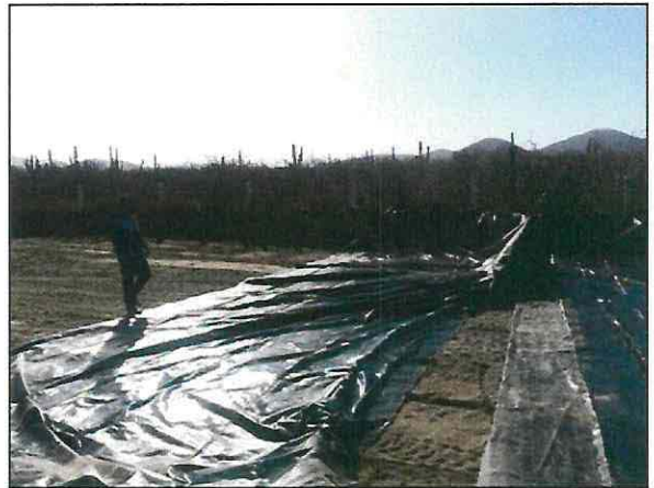
Colocación de liner.
