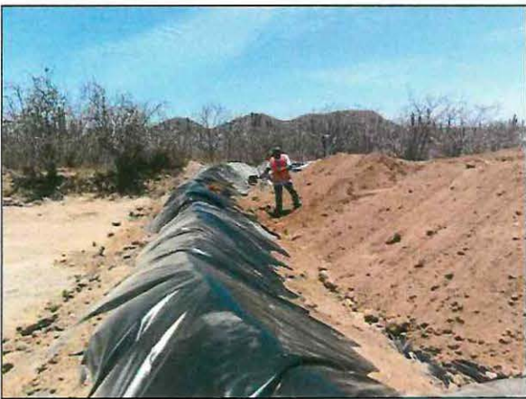
Con apoyo de recurso humano se acomodó el material edáfico contaminado dentro de la celda provisional.
