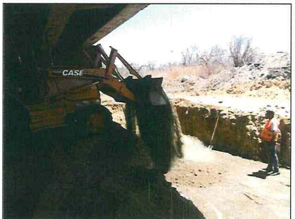
Colocación del material de relleno dentro de la fosa de excavación (caja o zona de extracción).
