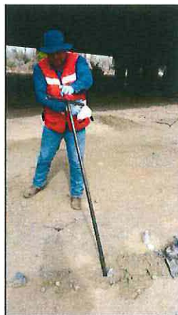
Se tomaron muestras en las paredes de la fosa de excavación (caja o zona de extracción).
