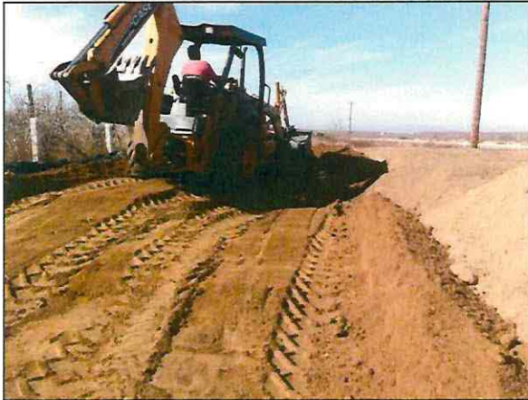
Construcción de la celda provisional.
