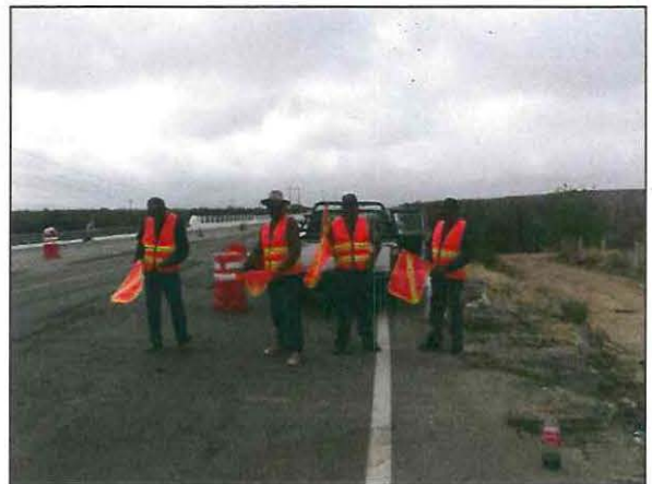
Personal humano abanderando la zona cercana al área de trabajo, como medida preventiva.
