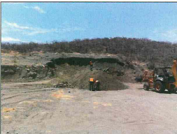
Extracción de material edáfico libre de contaminantes de un terreno ejidal, que fue utilizado como relleno para la fosa de excavación (Caja o zona de extracción).
