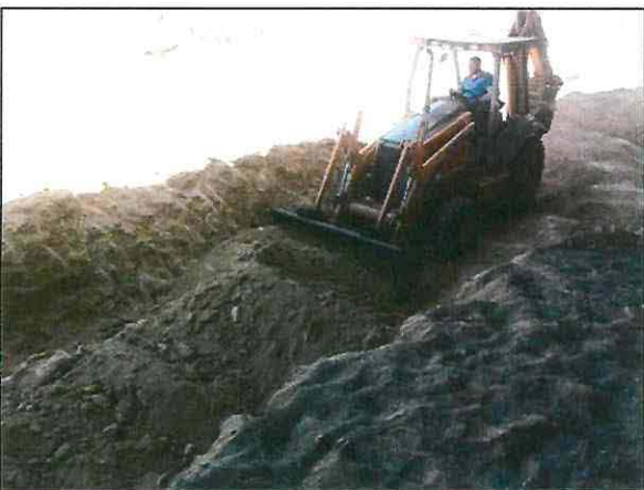
Dispersión del material edáfico utilizado como relleno para su posterior compactación.
