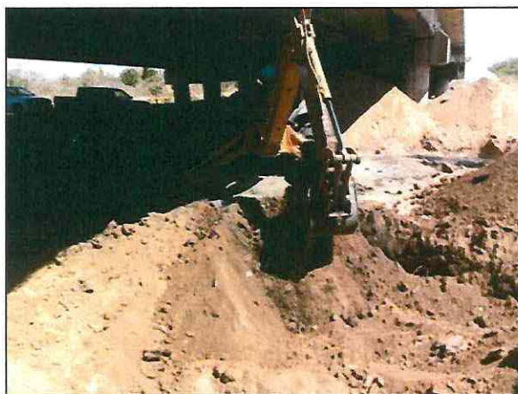
Extracción del material edáfico contaminado con Turbosina en la zona contaminada.
