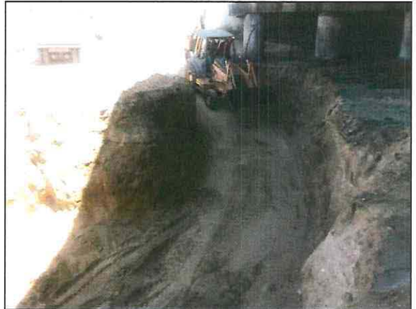
La fosa de excavación fue acondicionada para la entrada de maquinaria pesada con el material de relleno.
