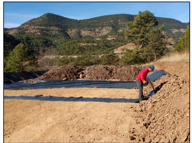
Colocación del liner
