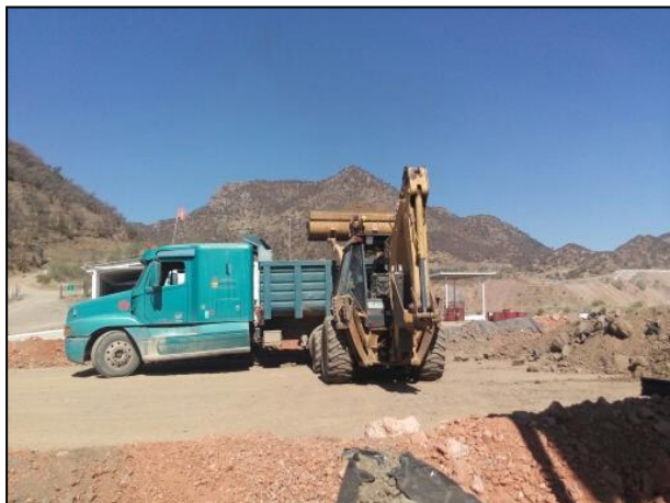
Acarreo del material de la celda provisional hacia la celda de tratamiento
