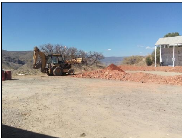
Construcción de la celda provisional en el almacén de residuos de la Mina Dolores
