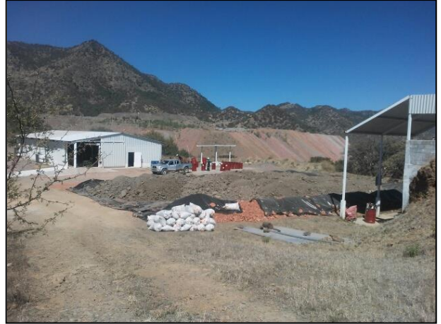
Vista de la celda provisional
