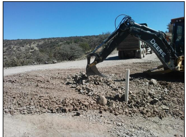
Dispersión del material edáfico utilizado como relleno. Se observan tubos de monitoreo para toma de muestras.
