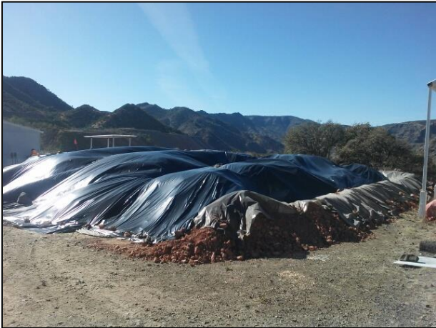
El material edáfico contaminado se cubrió con una película de polietileno de alta densidad.
