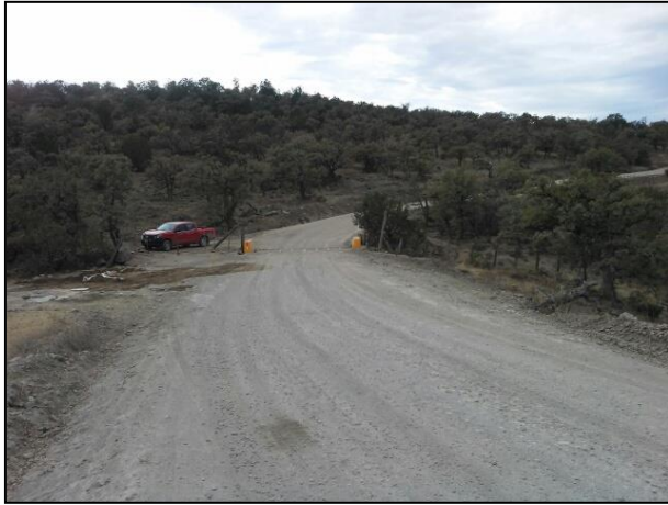
Ubicación del punto de impacto en el Km. 52 de la brecha Yepachi a Mina Dolores.
