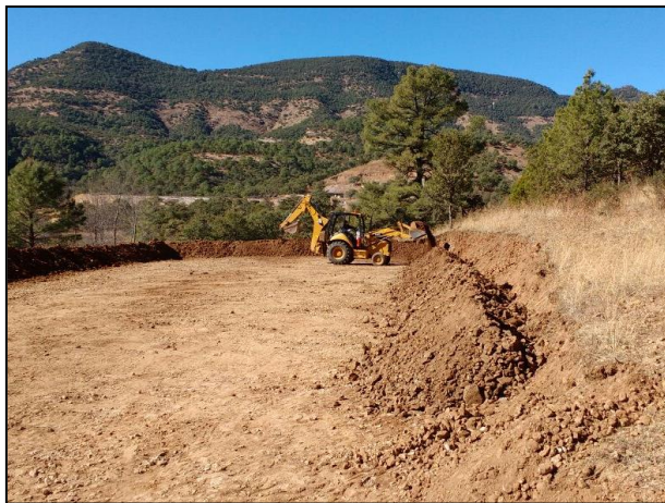
Construcción de la celda de tratamiento ubicada en un predio particular a 5 Km de la Mina Dolores
