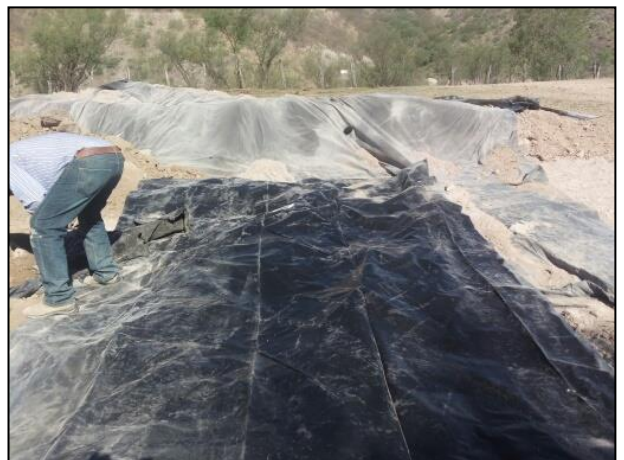
Colocación de liner.
