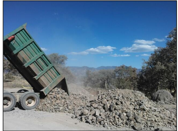
Para el relleno de la fosa de excavación fue utilizado material edáfico con propiedades semejantes y libres de contaminantes
