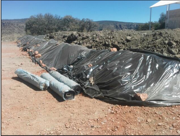
Bordes de la celda provisional
