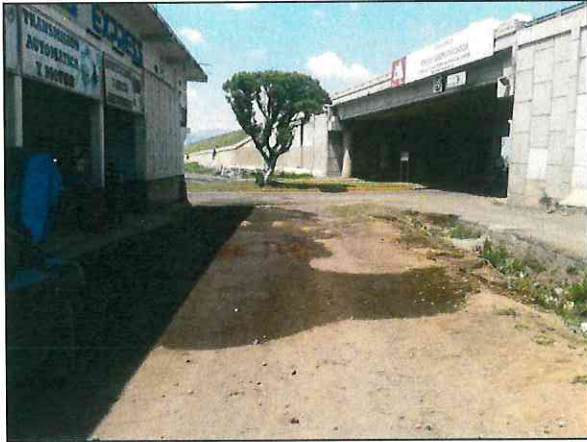
Sitio del accidente, en el Boulevard San Buenaventura esquina Circuito Exterior Mexiquense
