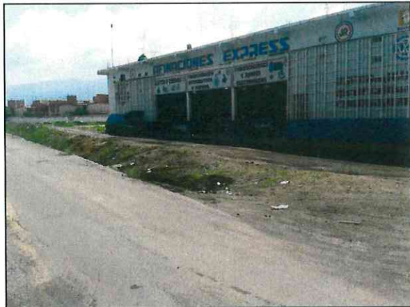
En donde se suscitó el derrame de Turbosina se observan locales comerciales
