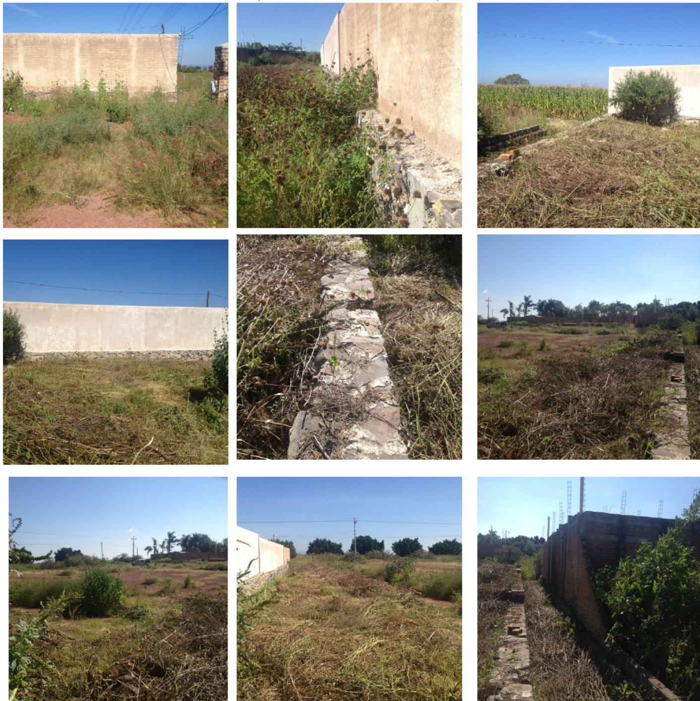
Aspectos actuales de la construcción de la cimentación de los muros perimetrales y oficina, ambos en obra negra.
