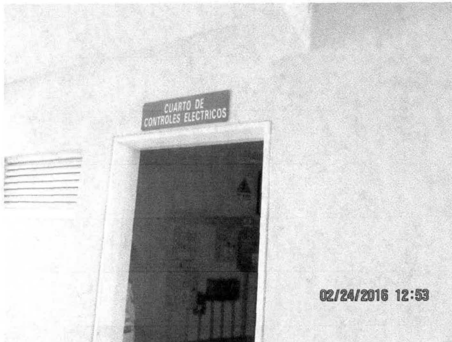
Fotografía No. 7.- Cuarto de controles eléctricos
