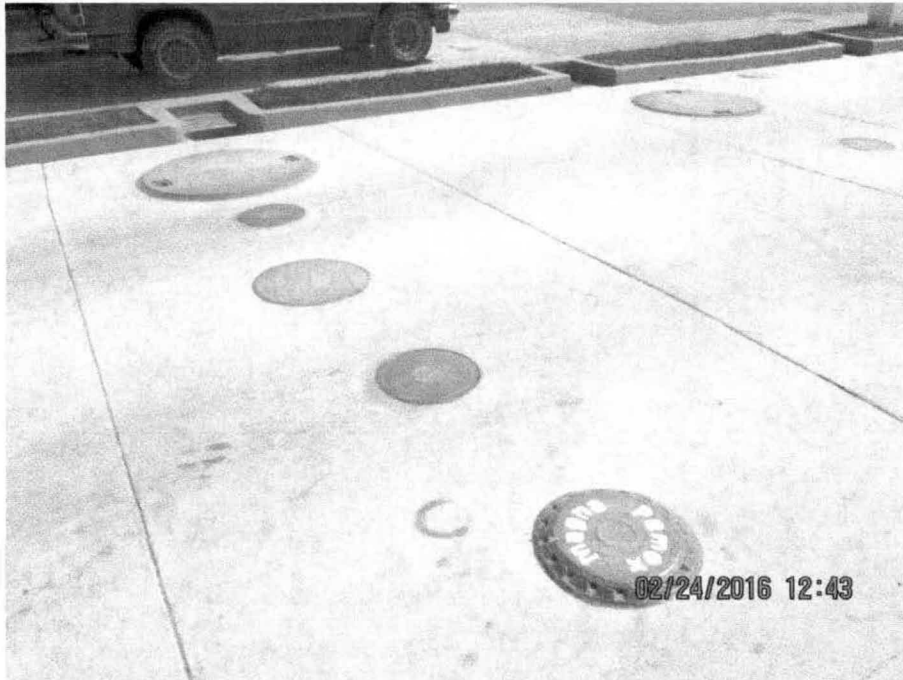
Fotografía No. 12.- Zona de tanques de almacenamiento de gasolina Magna
