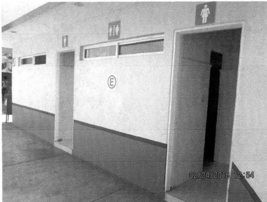
Fotografía No. 10.- Área de Baños
