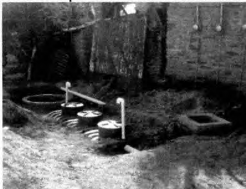
Figura 29. Microplanta MC3M con cisterna de 1.2m3
