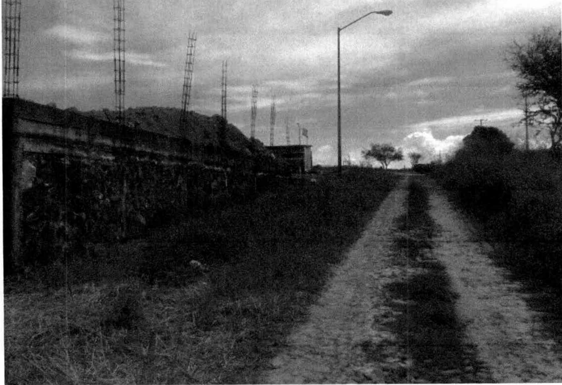
Frente sur, colindando con la avenida proyectada Paseo del Sol.
